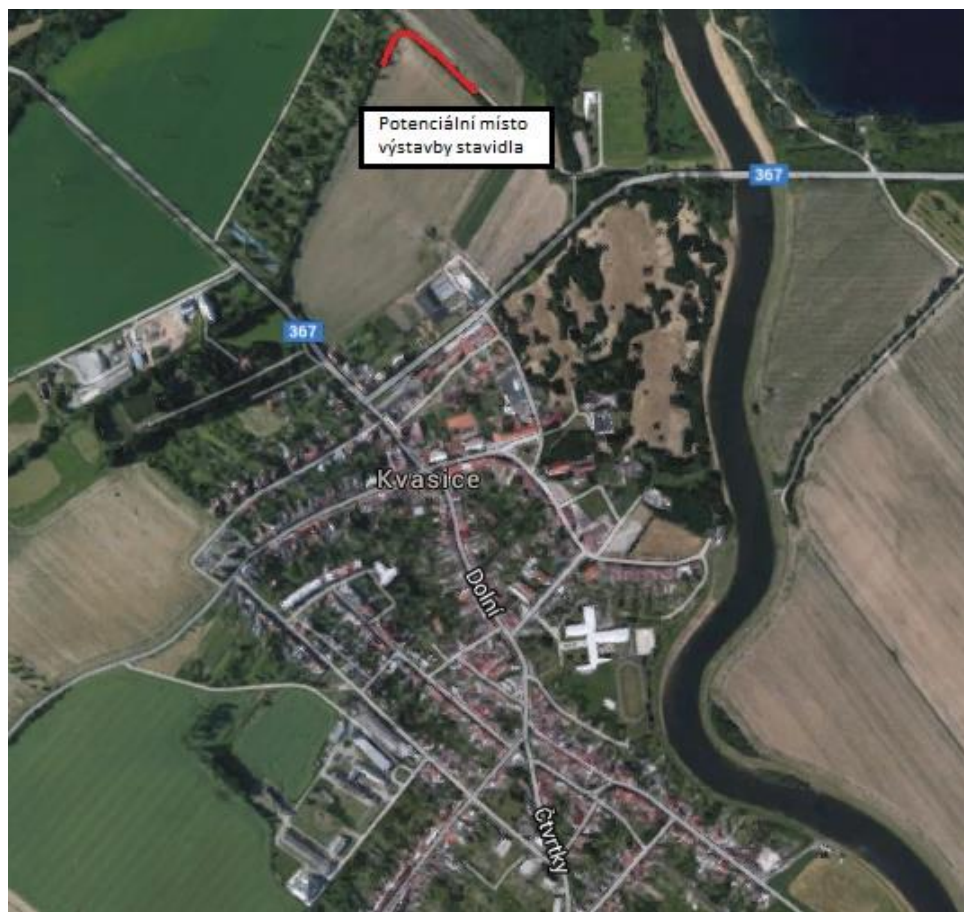
Obr. 24. Umístění stavidlového objektu [ Zdroj: Vlastní ]
