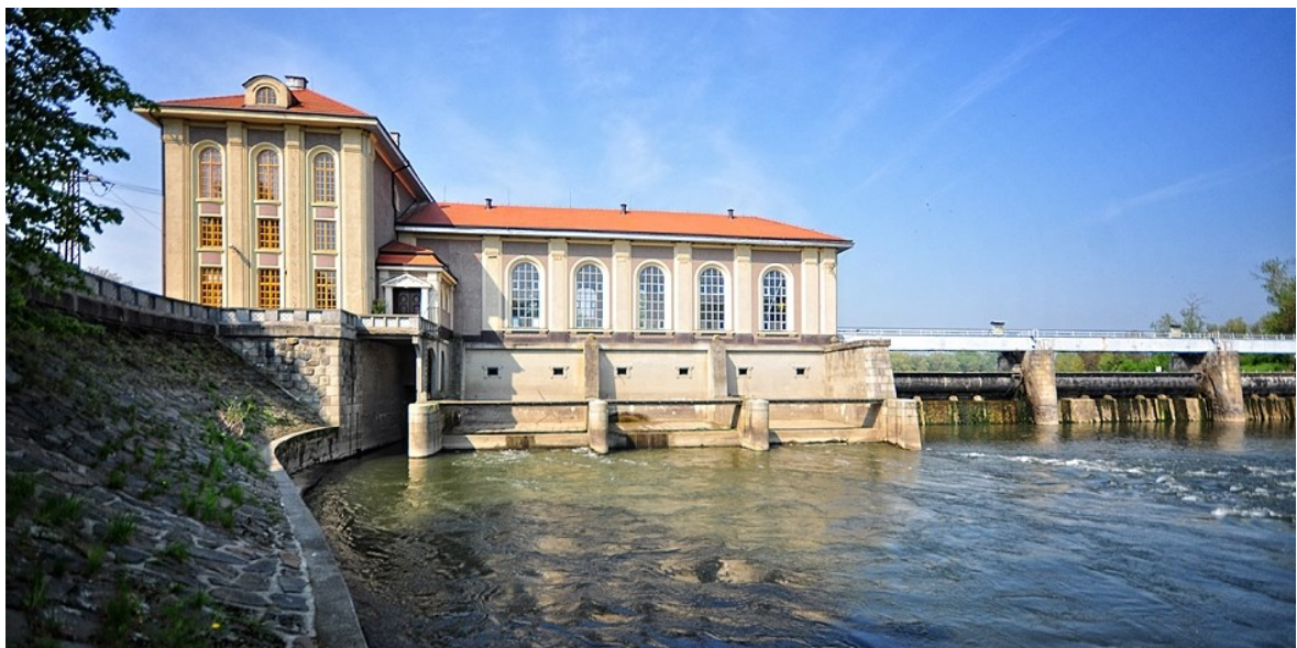
Obrázek 2 Vodní elektrárna Na Strži [47]
