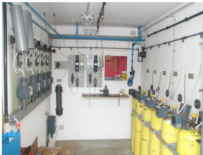
Obrázek 7: Nádoby s chlórem v ČOV Jihlava, zdroj: vlastní
