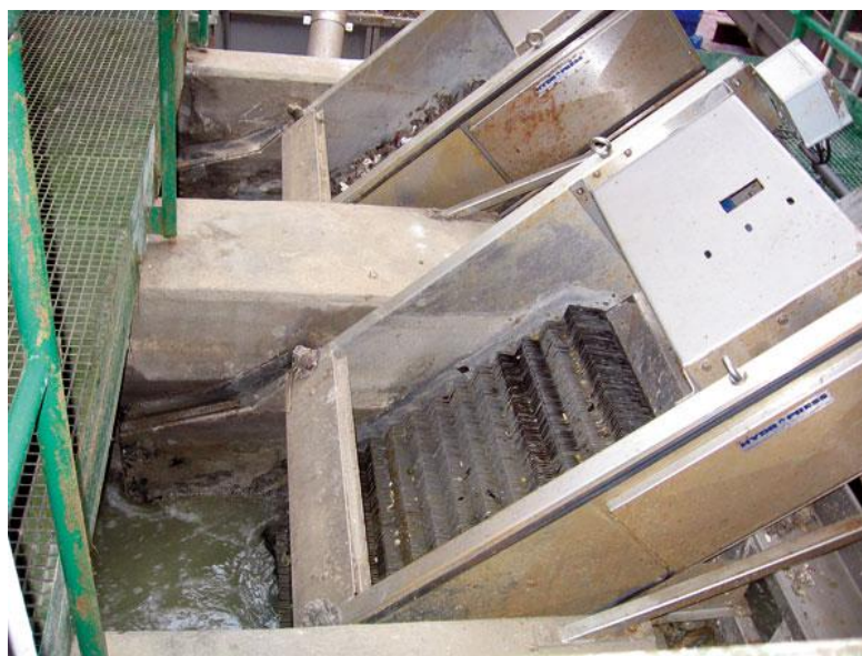
Obrázek 2: Česle v ČOV Jihlava; zdroj: vlastní
