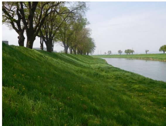
Obrázek 11 Úprava levobřežní hráze mezi UH a Jarošovem [24]
