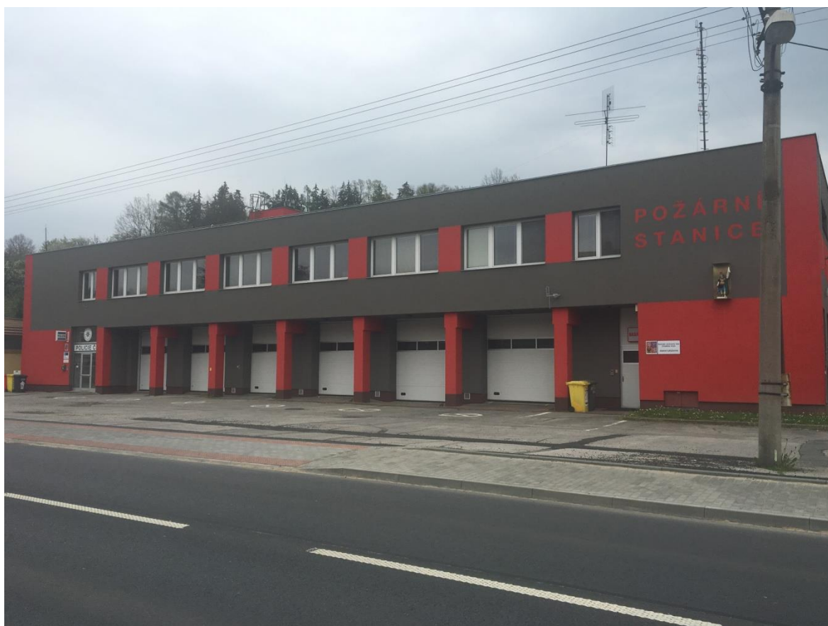
Obr. 4. Hasičská stanice Luhačovice [vlastní]
