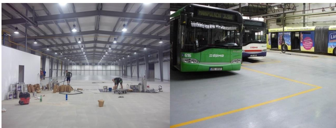
Obr. 30: Ukázka hlazení horní vrstvy a její užití [54].
