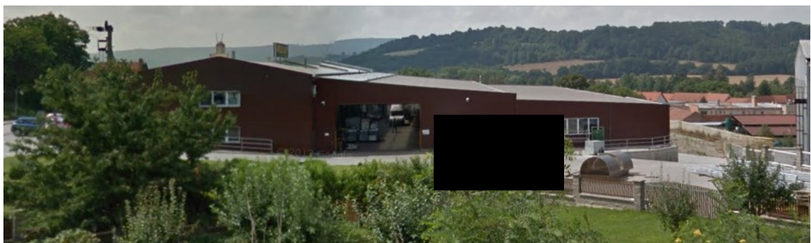
Obr. 28: Boční pohled na výrobní halu (Vlastní zpracování)
