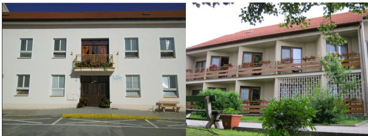
Obr. 5 Hlavní vstup a zadní část budovy Domova pro Seniory, Strážnice (Interní zdroje, 2016)
