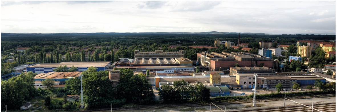
Obrázek 6 – Pohled na areál JMA (interní zdroj)
