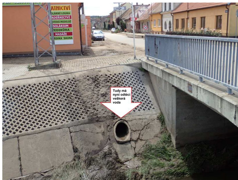
Obr. 16. Zpevnění břehů potoku [28]
