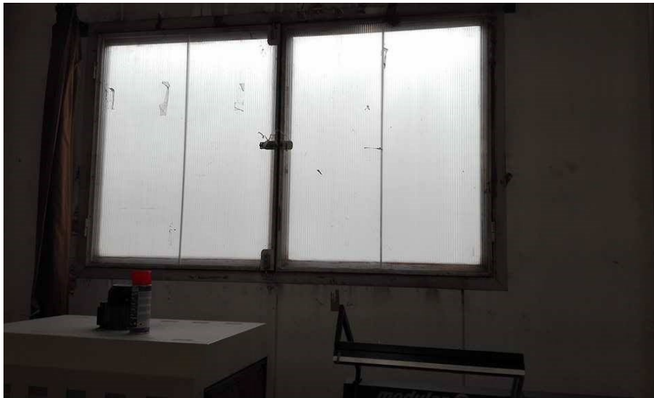
Obrázek 3 – Okno v dokončovací výrobě – Zdroj: [vlastní]
