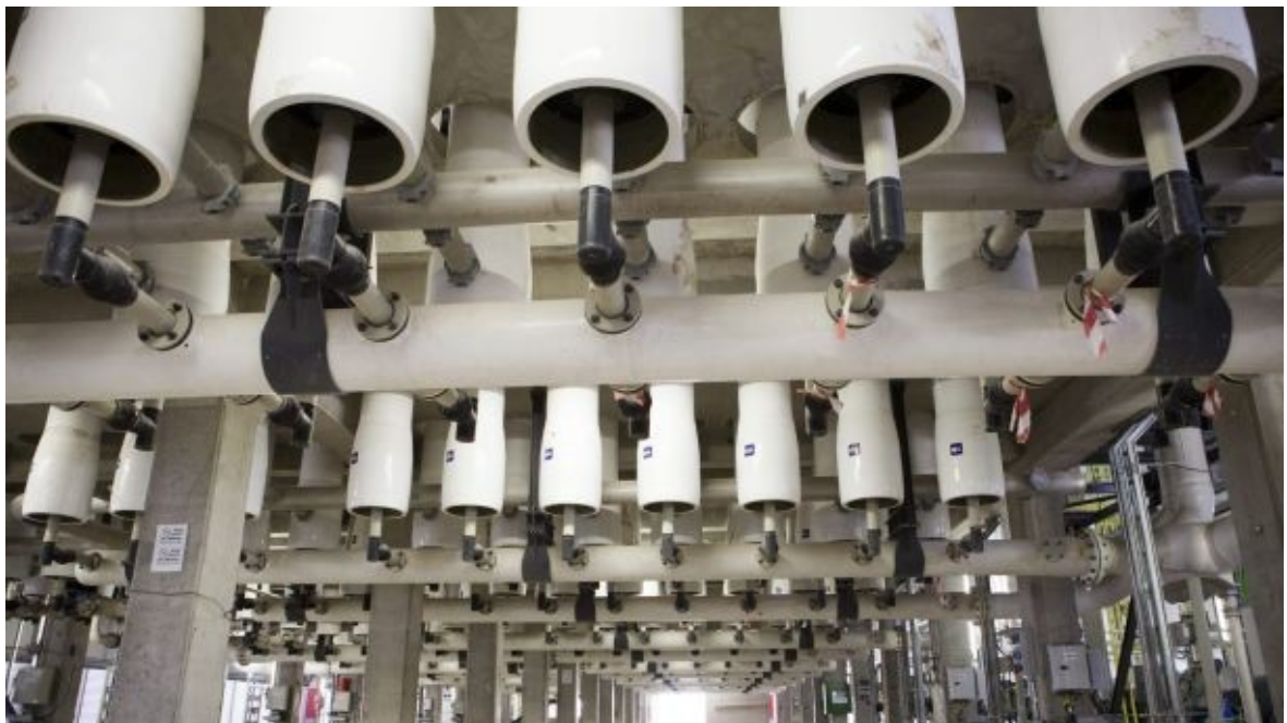
Obrázok č. 6: Odsol'ovacia jednotka
