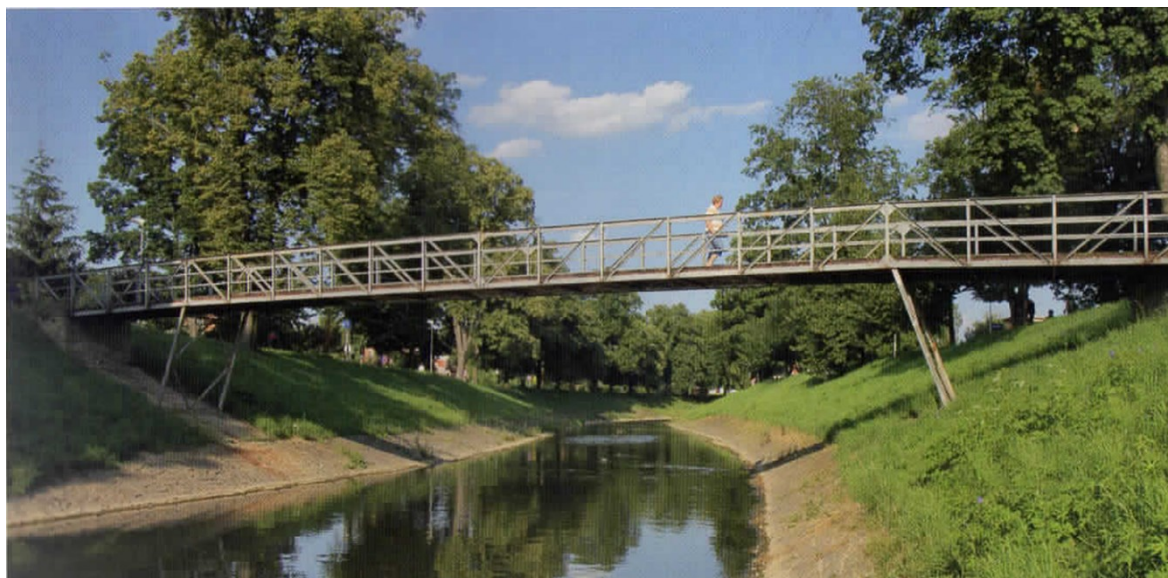
Obr. 13: Bývalá lávka mezi Zálešnou a Podvesnou
