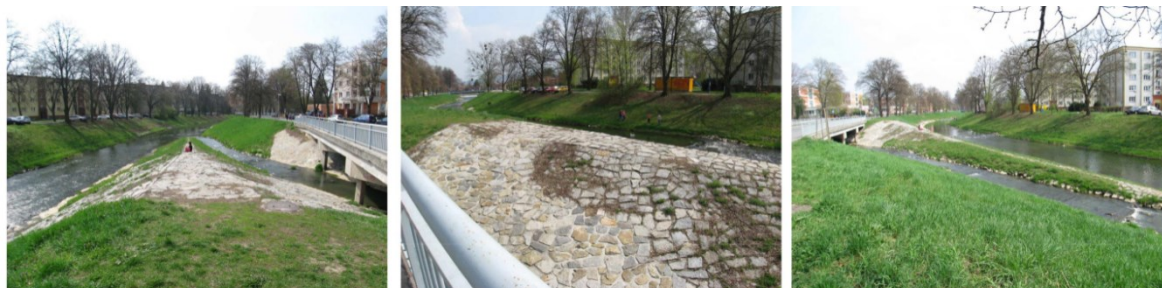
Obr. 29: Odpočinková plocha na Havlíčkově nábřeží u soutoku Frýštáckého potoka
