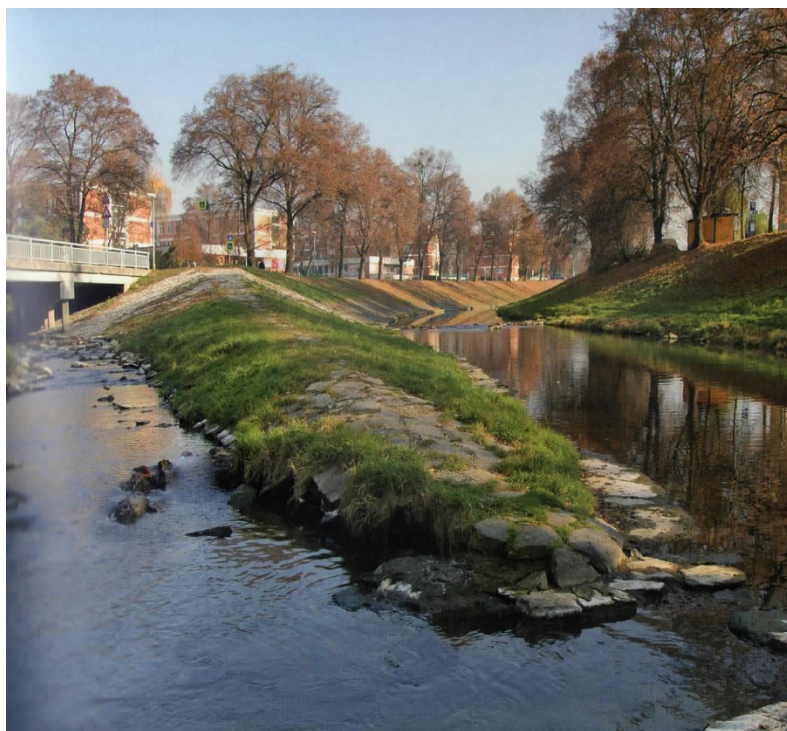
Obr. 12: Soutok Dřevnice s Frýštáckým potokem (Janušnice)
