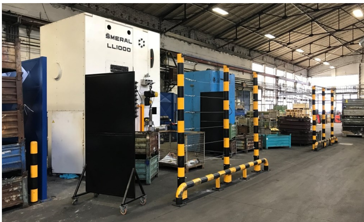
Obrázek 56: Stav realizace projektu k 6. 4. 2018 (interní materiály firmy)
