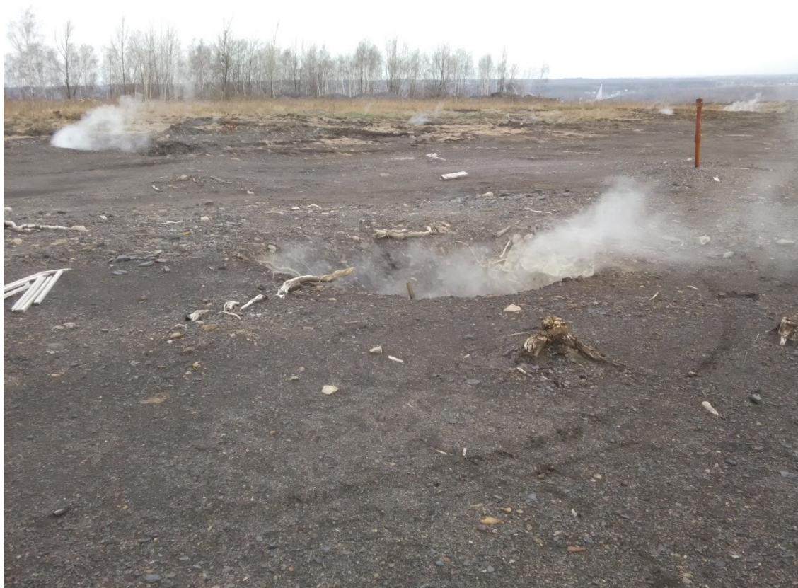
Obrázek 4: Projevy termické aktivity na vrcholu odvalu Heřmanice (výstup par a celková devastace vegetace)
