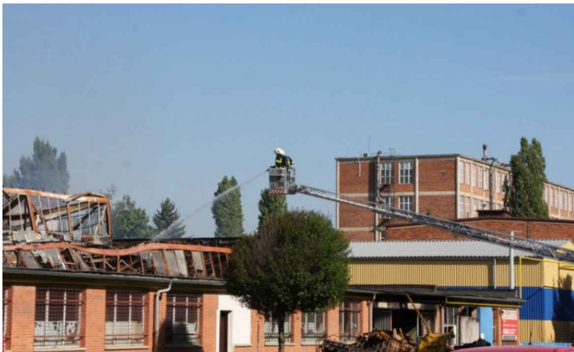
Obrázek 15: Budova po uhašení požáru [Zdroj: 42]
