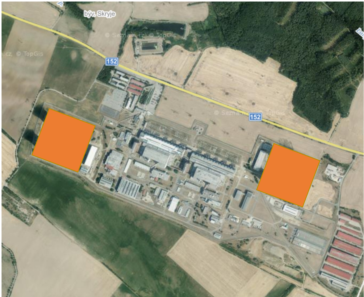
Obr. 30 - znázornění chladících věží (17)
