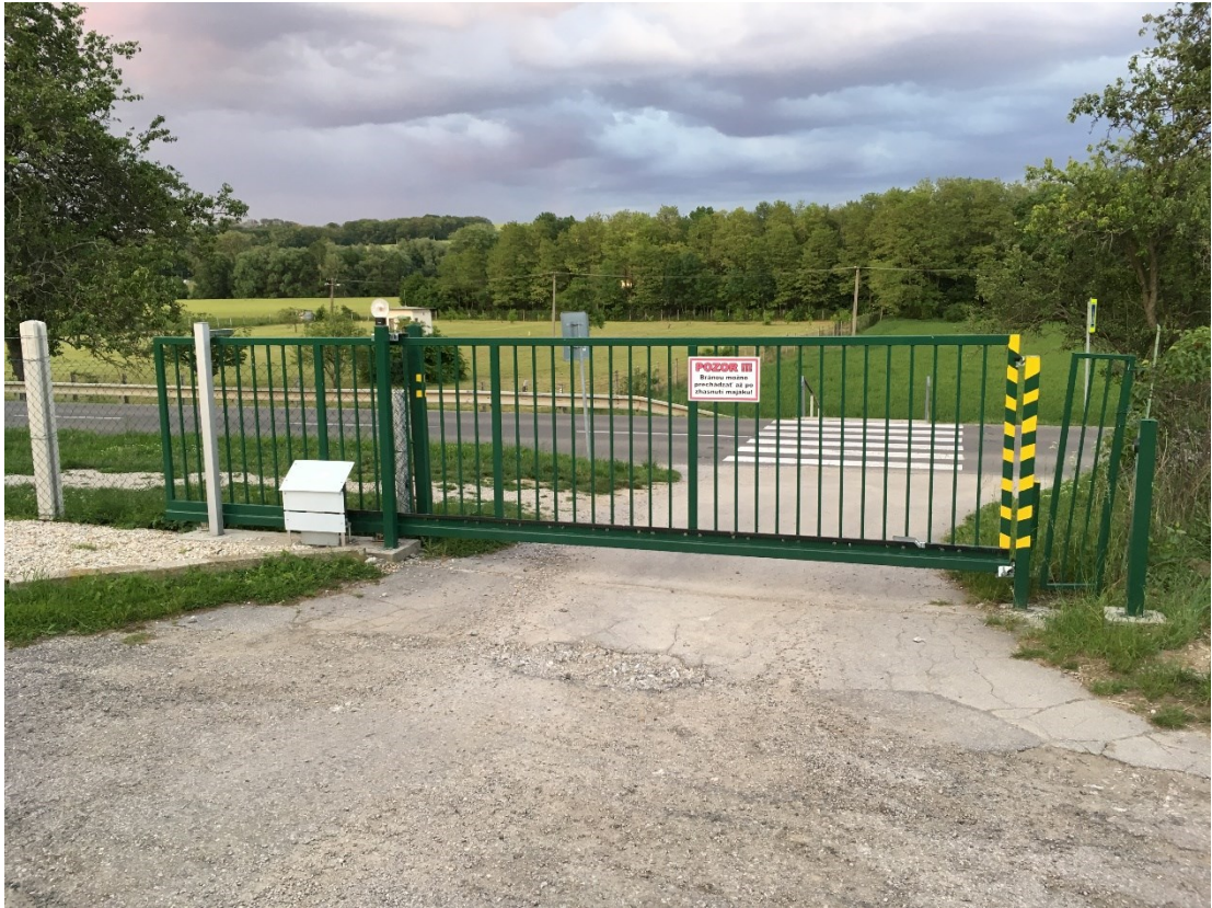
Obrázok 8: Automatická posuvná brána[zdroj: autor]
