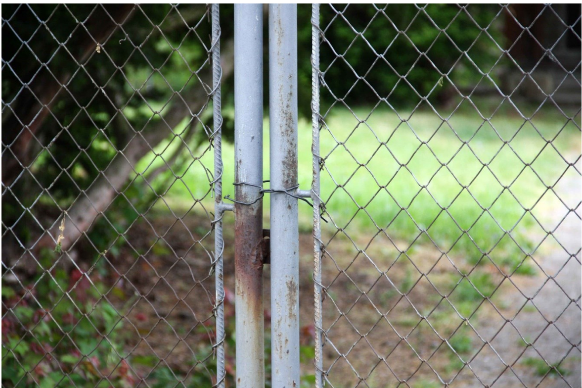
Obrázek 17 Detail aktuálního zabezpečení
