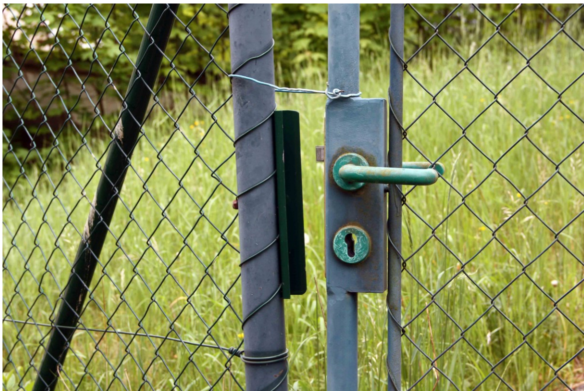
Obrázek 13 Detail aktuálního zabezpečení
