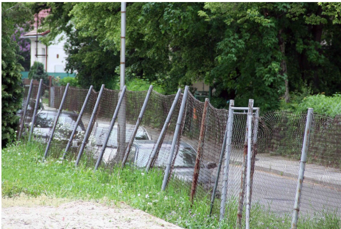
Obrázek 3 Oplocení před budovou staré školy
