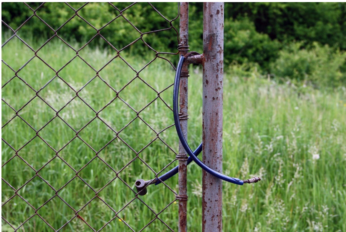
Obrázek 7 Detail aktuálního zabezpečení
