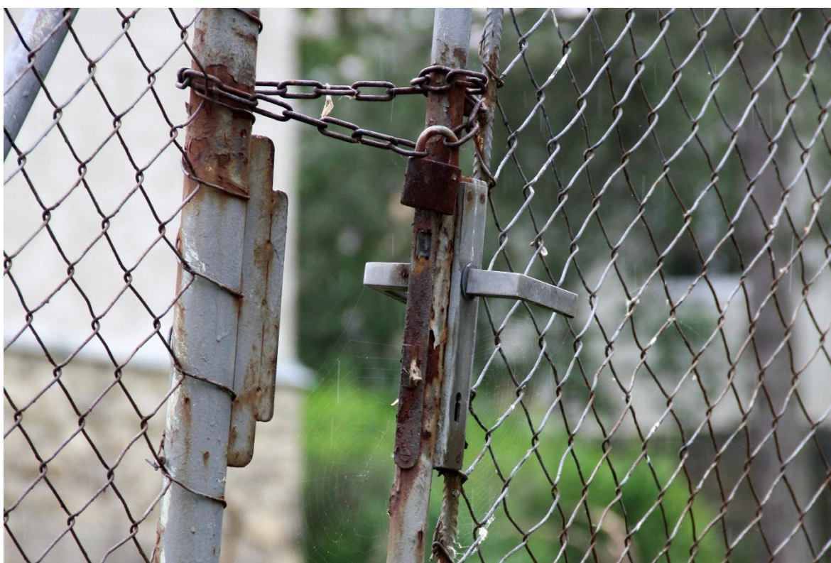
Obrázek 18 Detail aktuálního zabezpečení před budovou staré školy
