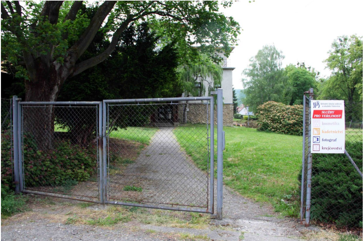
Obrázek 16 Brána s brankou vedoucí k hlavnímu vchodu budovy staré školy
