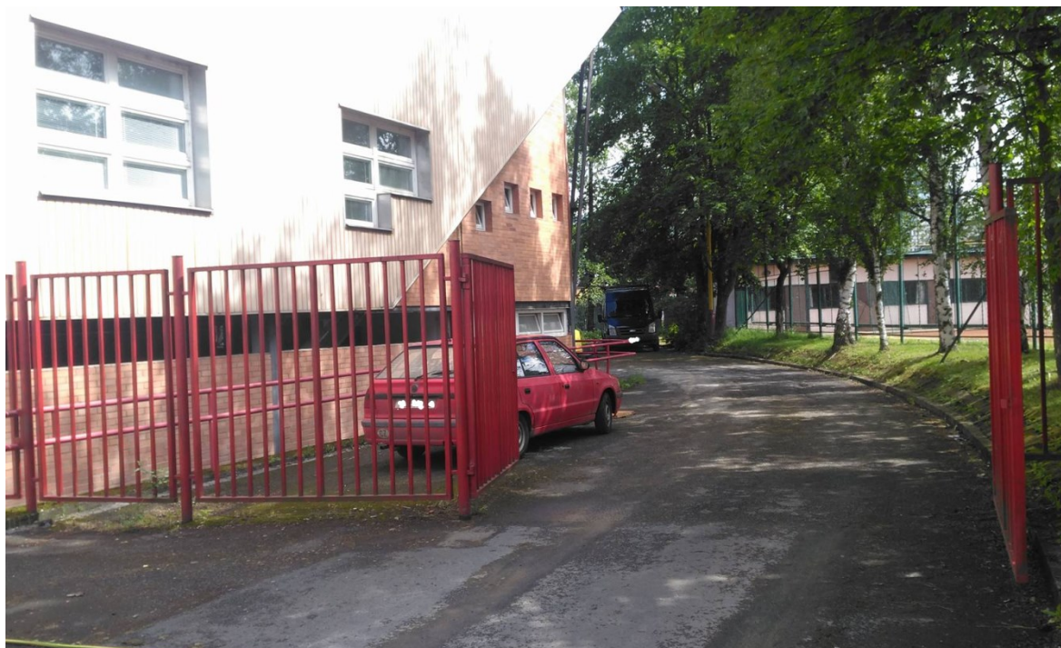
Obr. 13 Vjezd do zadní části stadionu
