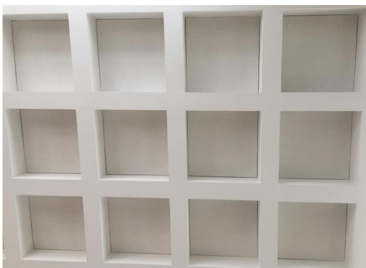
Obr. 16 Absorbéry na stropě kostela Panny Marie Pomocnice křesťanů
