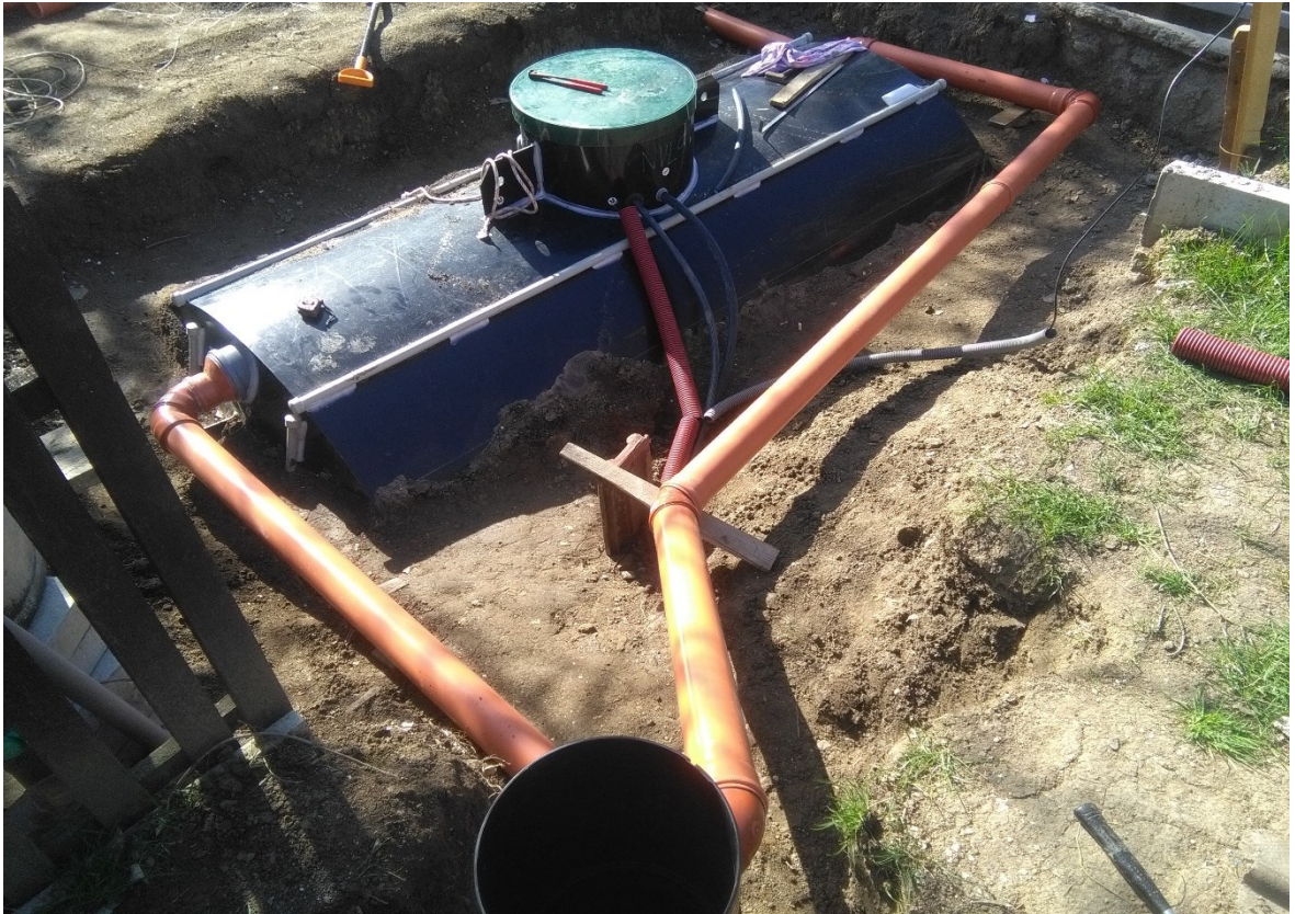
Obrázek 19 – Připojení nádrže k okapům a na přepad filtračního sýta. [zdroj vlastní]
