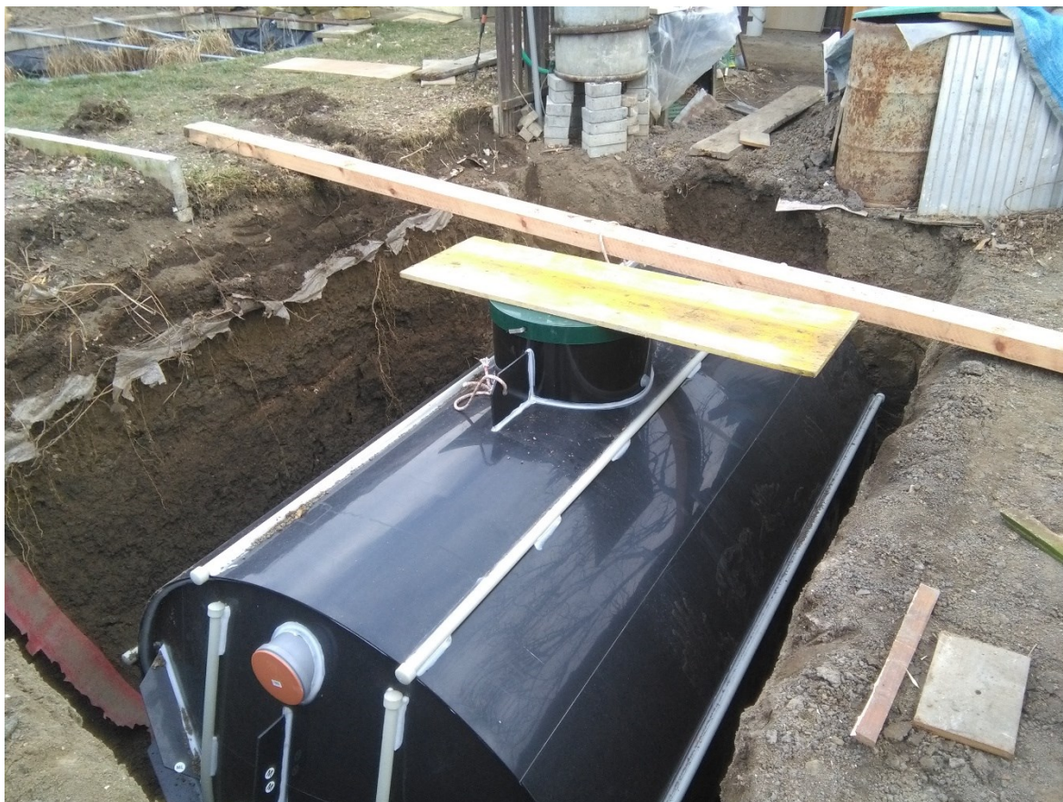
Obrázek 17 – Uložení nádrže do připravené jámy. [zdroj vlastní]
