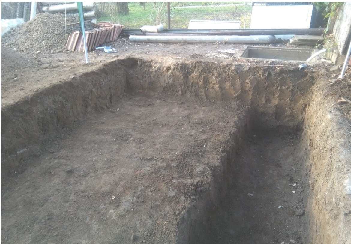
Obrázek 16 – Příprava jámy na nádrž (ruční výkopové práce). [zdroj vlastní]
