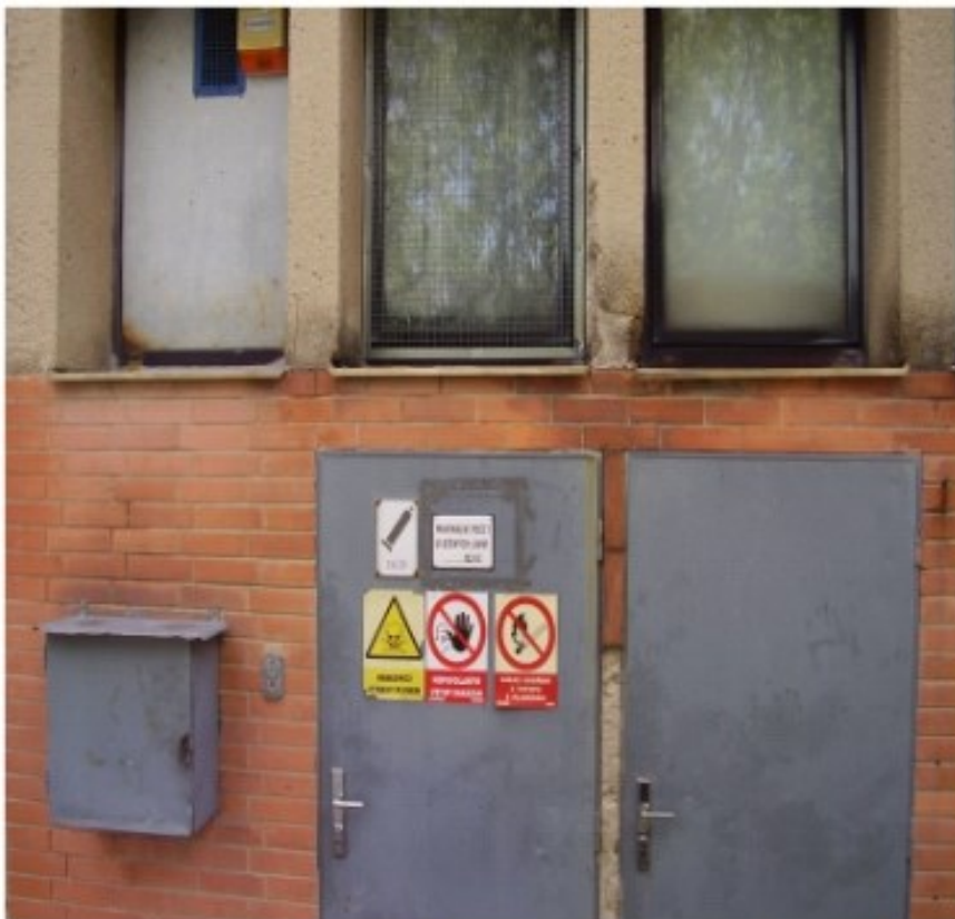
Obrázek 2 Vstup do chlorovny [12]
