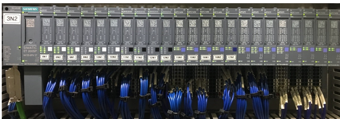
Obrázek 33 - Sestava vzdálených I/O vstupů
