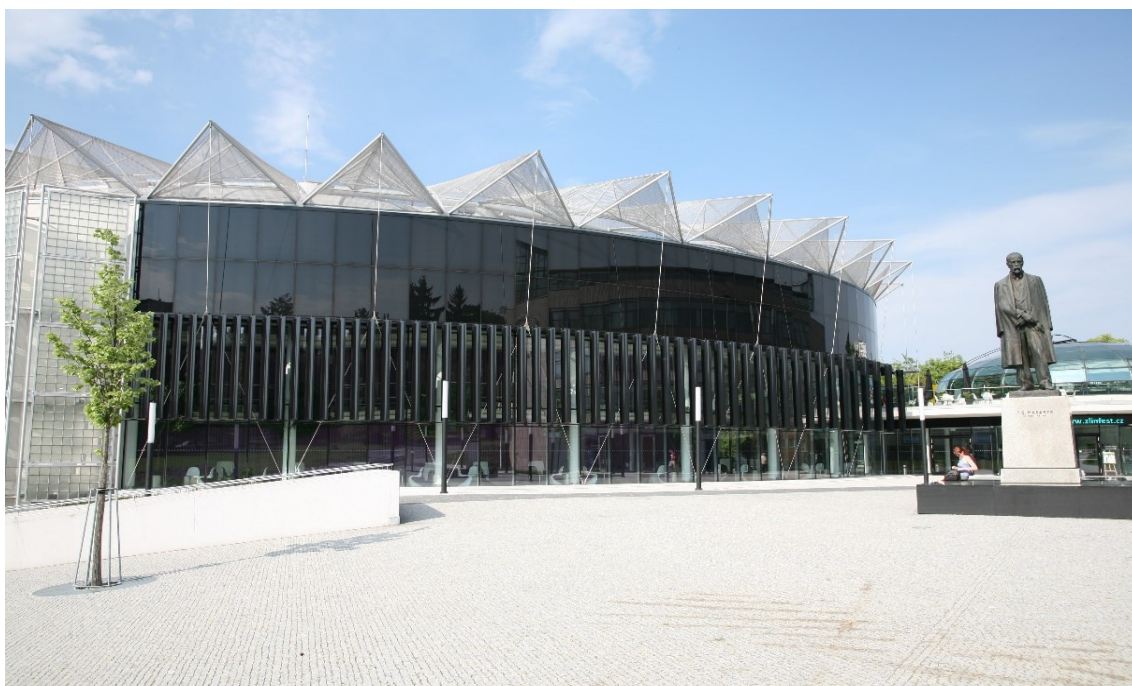
Obrázek 9: Vertikální svislé slunolamy na kongresovém centru (interní materiály)
