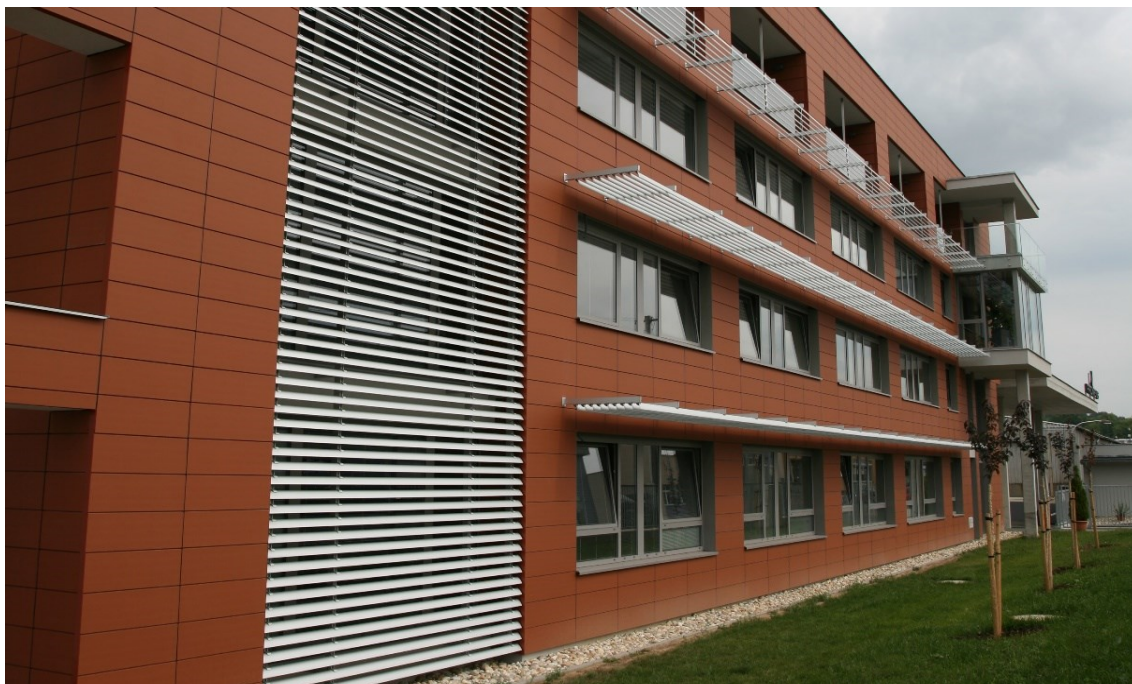
Obrázek 8: Horizontální slunolamy ve Zlíně (interní materiály)
