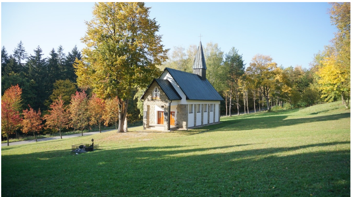
Obr. 15 Fotodokumentace - Kaple Panny Marie Bolestné na Ploštíně
