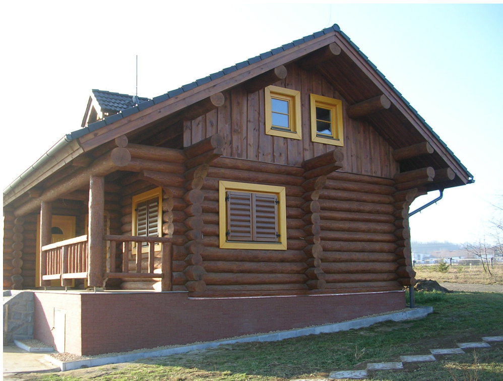
Obr. 16. Pohled z východní strany
