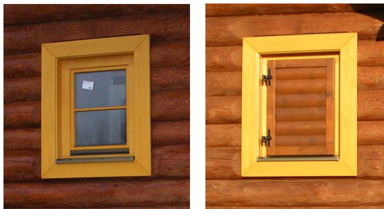
Obr. 14. Okno v přízemí před a po instalaci okenice
