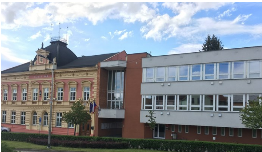
Obrázek 10: Sídlo budovy MěÚ Vizovice na Masarykově náměstí (vlastní foto)
