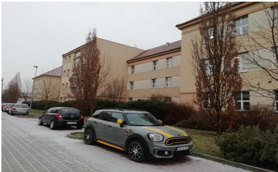
Obrázek 5 – Pohled na budovu ze severní strany (vlastní zpracování)
