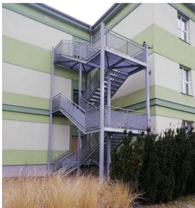
Obrázek 20 – Nouzové schodiště na budově UTB FLKŘ (vlastní zpracování)
