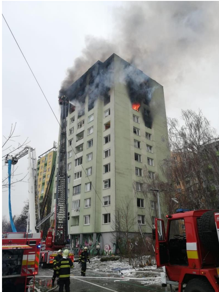
Obr. 8 Výbuch plynu v bytovom dome v Prešove [25]
