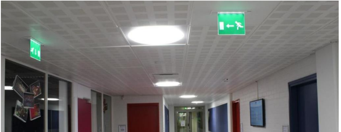
Obr. 20 Núdzové osvetlenie a navádzacie svietidlá [36]
