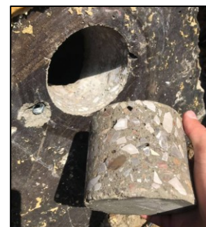
Obrázek 9. Vyvrtání betonového podkladu.
