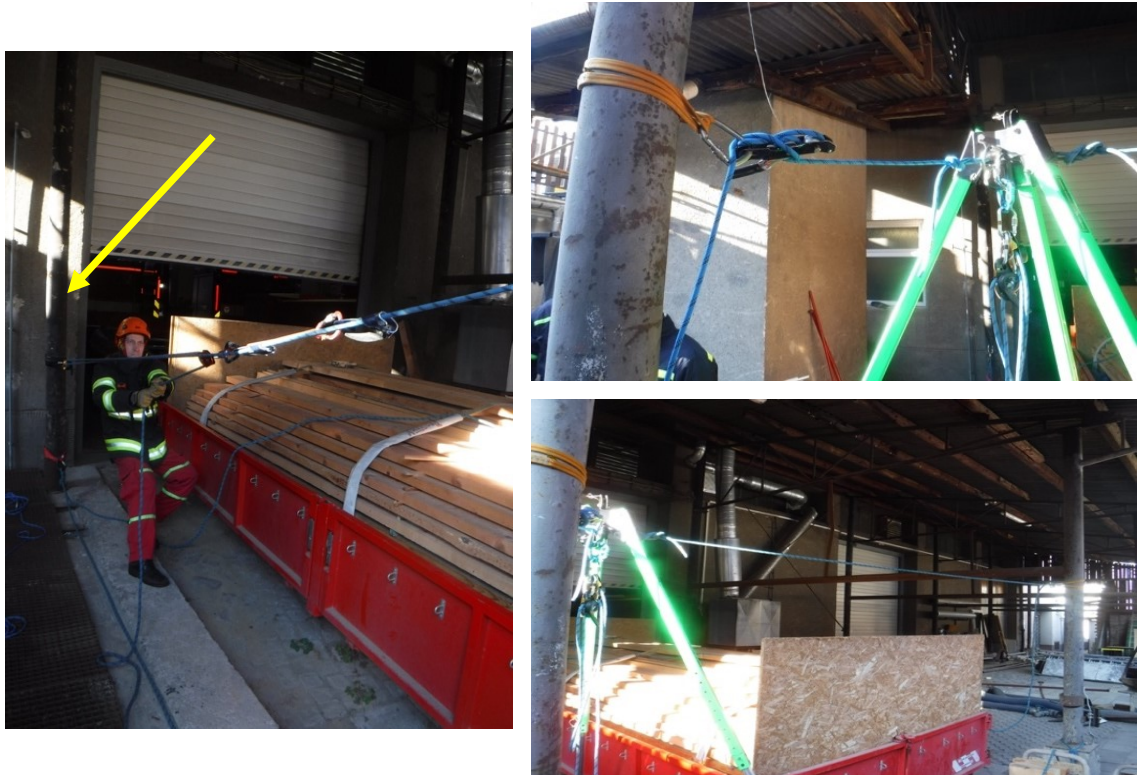
Obrázek 13 – Kotevní body pro kladkostroj [Vlastní zpracování]
