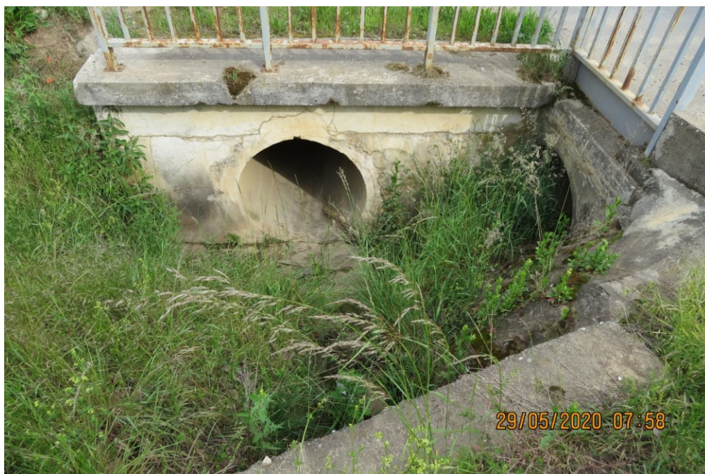
K5 – Propustek příkopy u křižovatky III/4973. [1]
