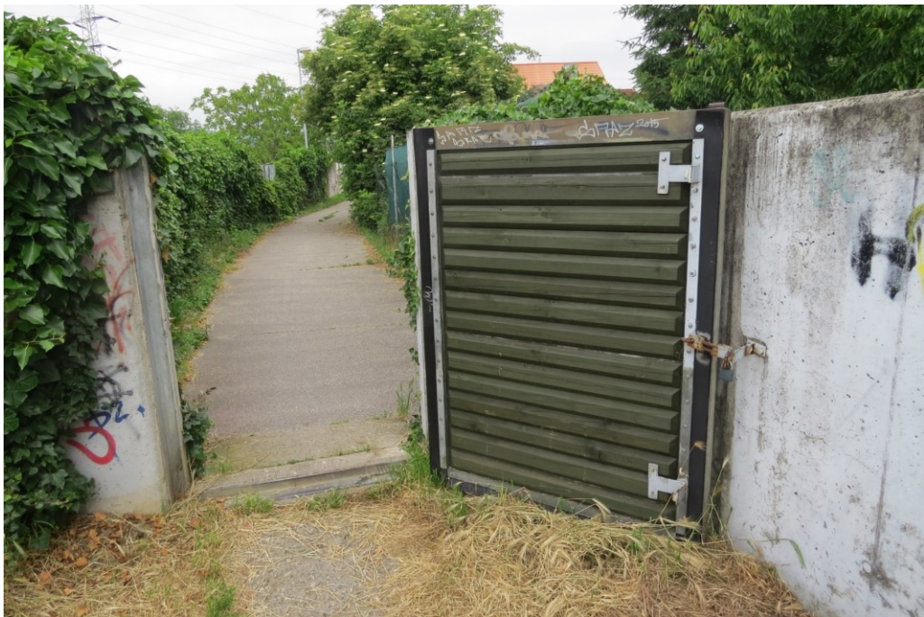
D8 – Ochranná zeď pravého břehu Dřevnice u č. p. 136 ul. Palackého. [1]
