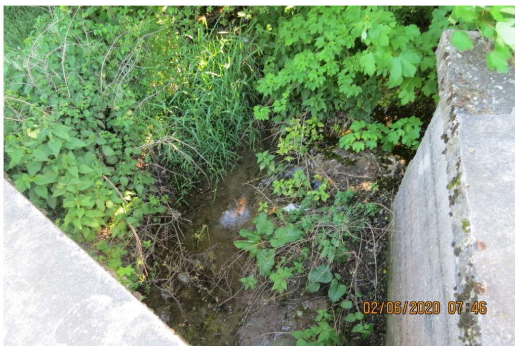
Propustek na Dřevnici pod silnicí na Machovou. [1]
