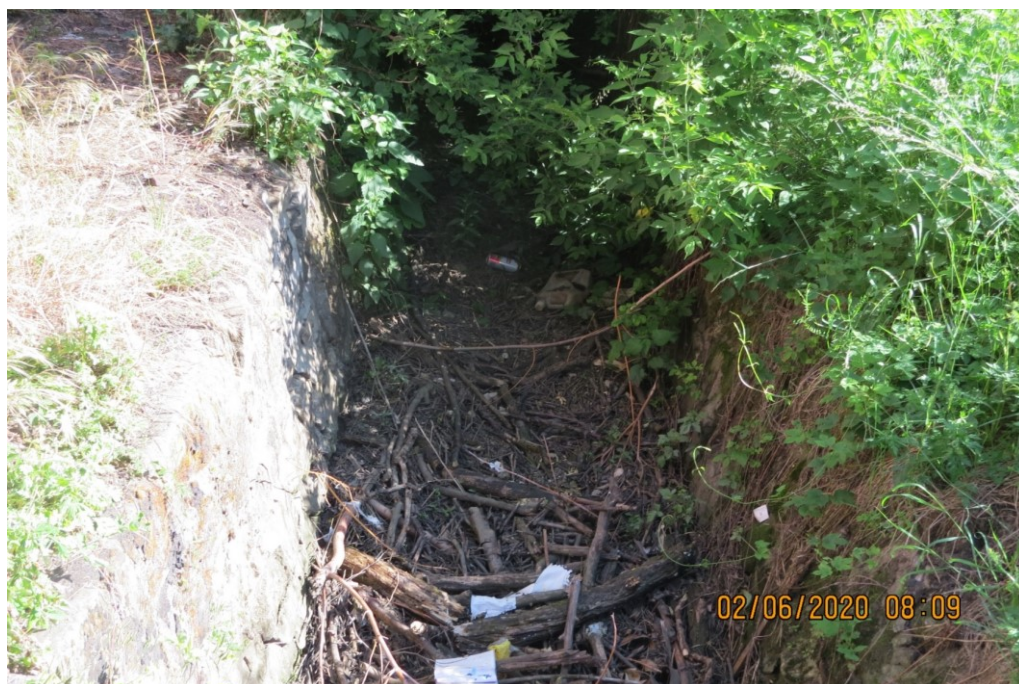
Koryto Hrabůvky nad železničním mostem. [1]
