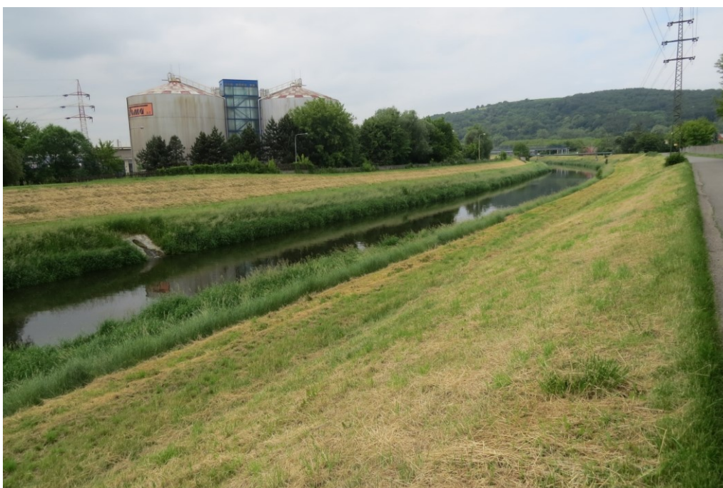
Koryto Dřevnice u ČOV. [1]
