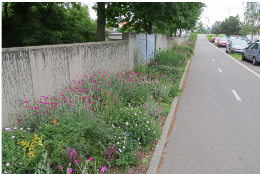
D19 – Mobilní hrazení na levém břehu nad lávkou. [1]
