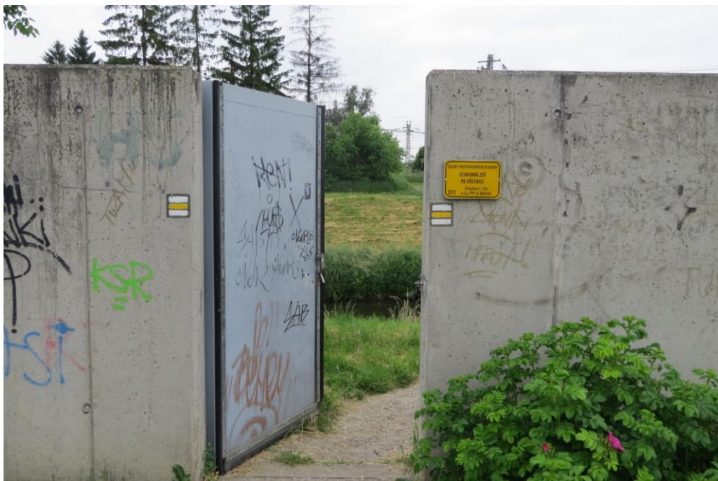
D11 – Ochranná zed' pravého břehu Dřevnice u č. p. 799 ul. Nábřeží. [1]
