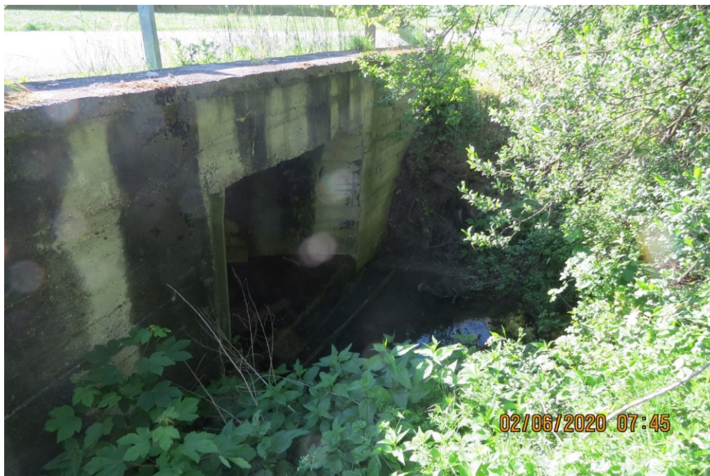
Propustek na Dřevnici pod silnicí na Machovou. [1]
