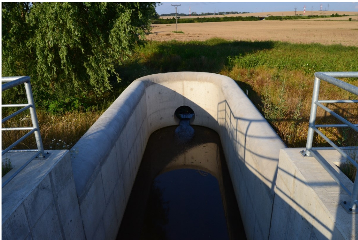
Sdružený funkční blok na vodním toku Hrabůvka. [Vlastní]
