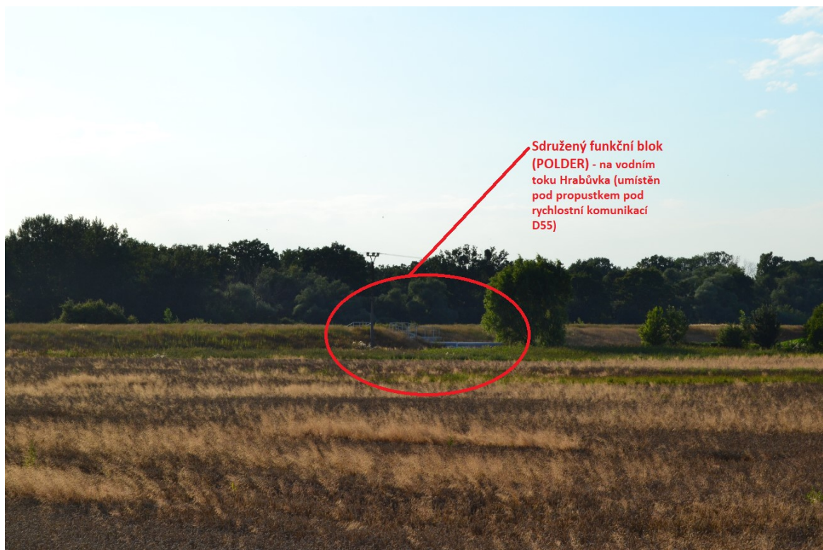
Nově vybudovaný sdružený funkční blok (Polder). [Vlastní]
