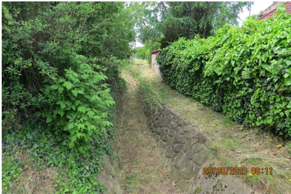
K9 – Příkop a propustek u ul. Hálkova. [1]
