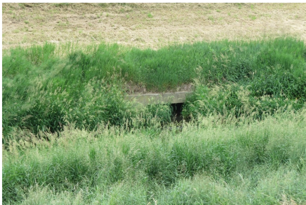
Vyústění Hrabůvky do Dřevnice. [1]
