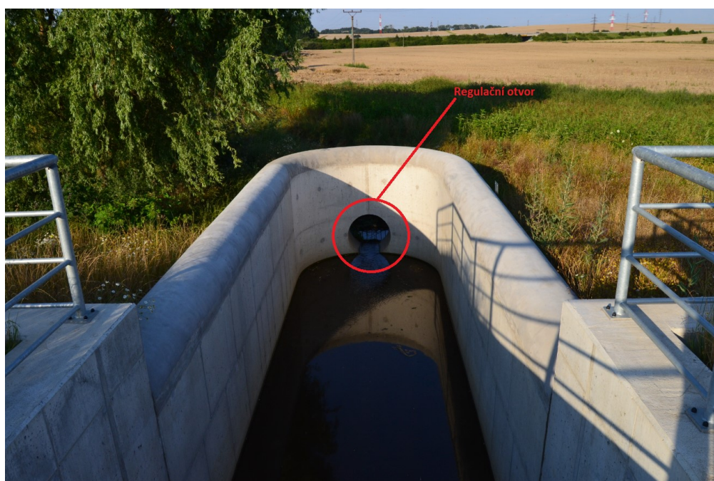
Obrázek 16. Otvor zajišťující regulaci průtoku sdruženým funkčním blokem poldru [Vlastní]
