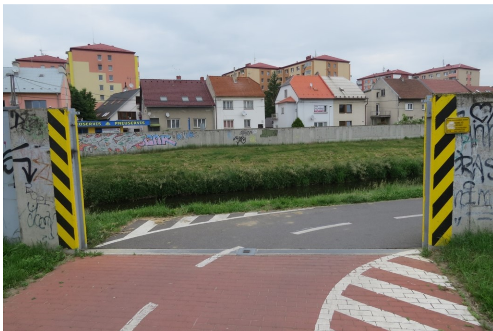
D16 – Ochranná zeď levého břehu (Mobilně hrazený průjezd cyklostezky. [1]
