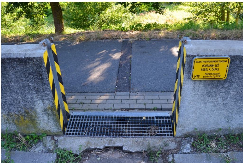
M10 – Mobilně hrazený průchod u č. p. 1130 – ul. K. Čapka. [Vlastní]
