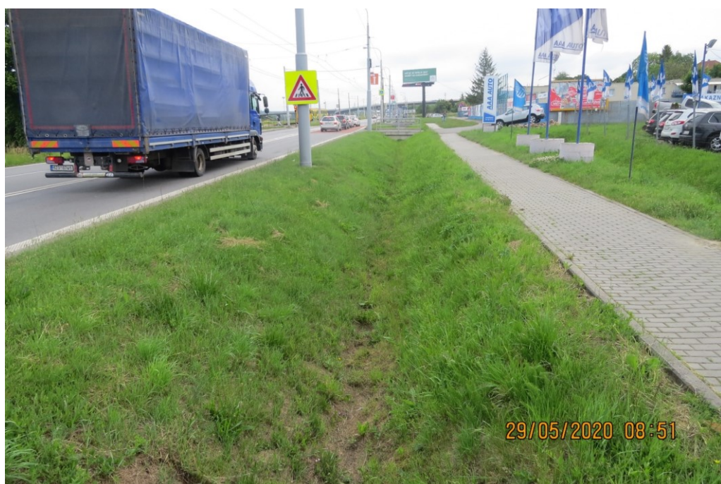
K12 – Příkop podél I/49 ul. Zlínská. [1]
