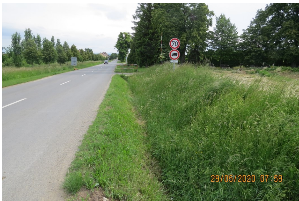
Příkop s propustky podél silnice III/4973. [1]
