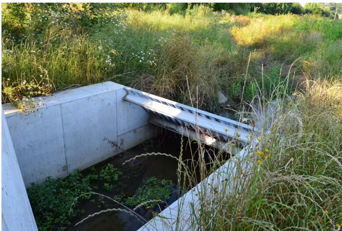
Česle u přítoku k sdruženému funkčnímu bloku směrem od propustku pod D55. [Vlastní]
