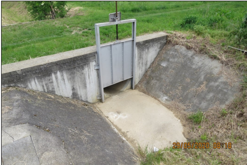
K8 – Propustek s hradítkem. [1]
