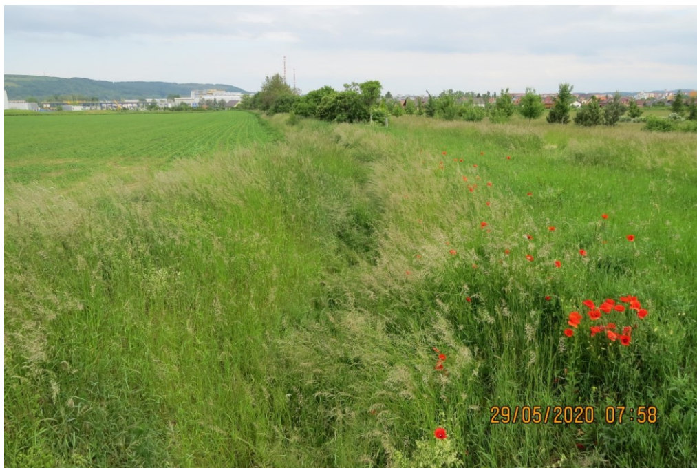
K15 – Příkop od propustku pod komunikací III/4973. [1]
