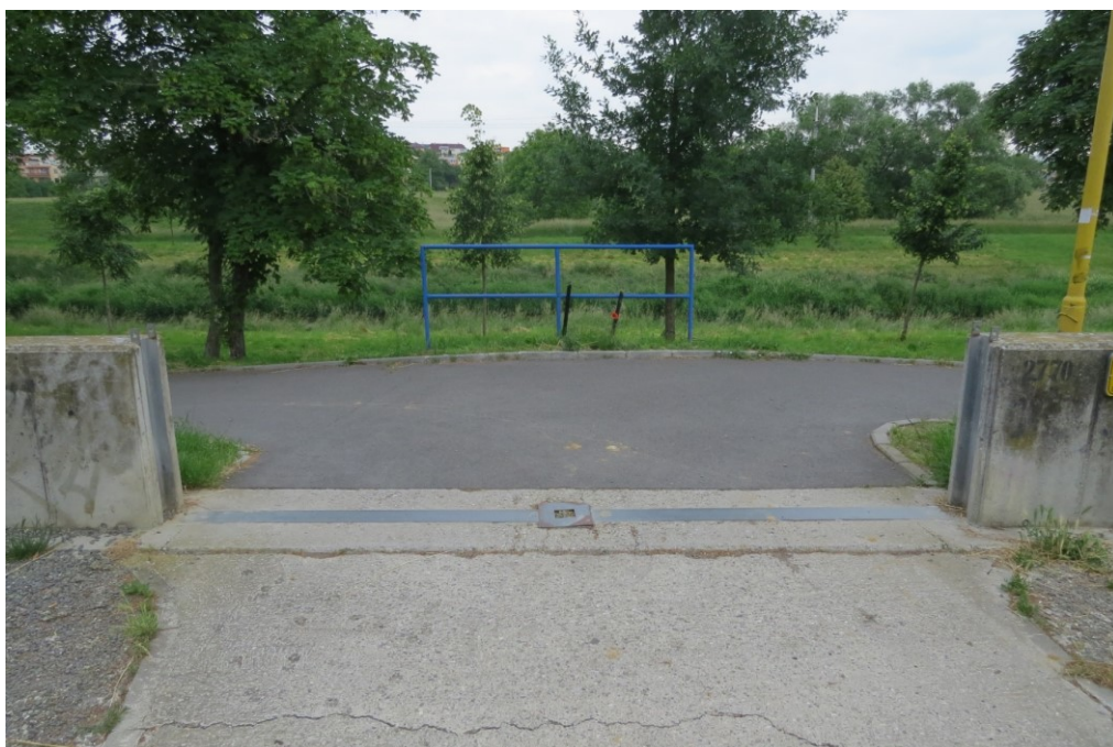
D26 – Ochranná zeď levého břehu. [1]
