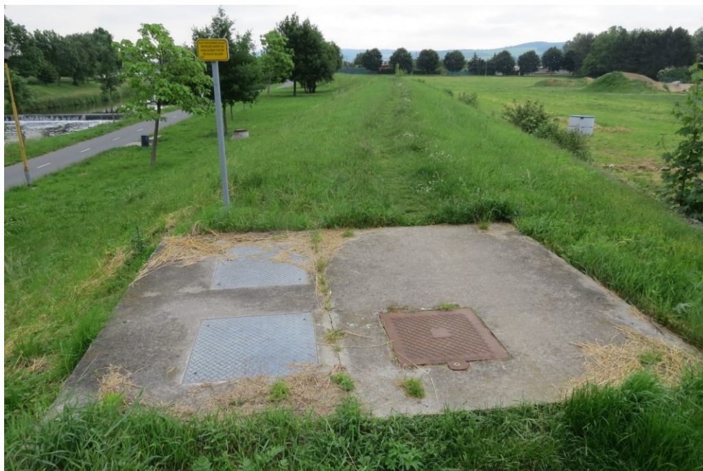
D27 – Stavidlové uzávěry na kanalizačním vyústění pod malým splavem. [1]
