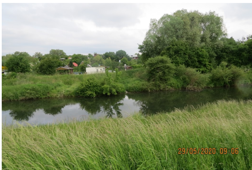
Zaústění Buňovského potoka do Dřevnice. [1]
