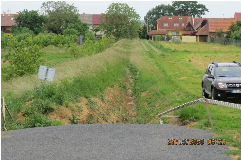
K7 – Koryto odvodňující plochy východně od skládky Kvítkovice – pod dálnicí. [1]
