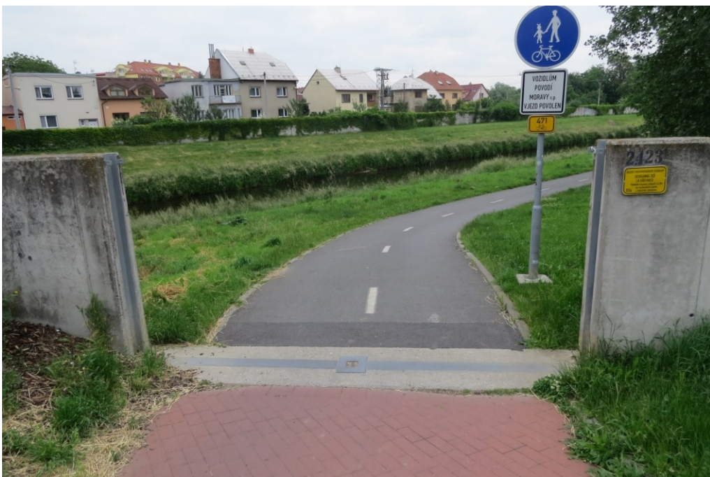
D24 – Mobilně hrazený příjezd u hasičské zbrojnice. [1]
