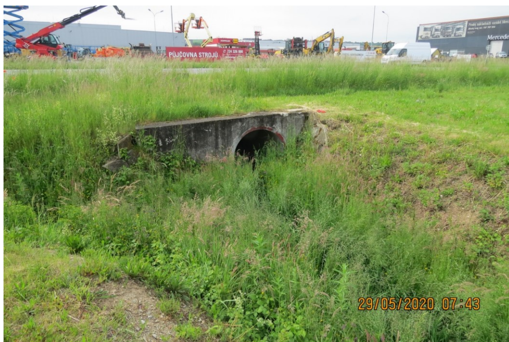
K11 – Propustek od I/55 zatrubnění pod areál PSG směrem k Moravanu. [1]
