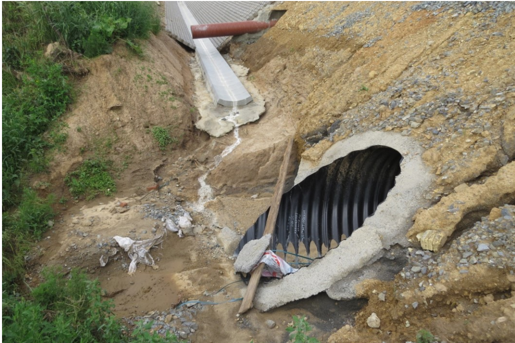
K7 – Koryto odvodňující plochy východně od skládky Kvítkovice – nad dálnicí. [1]
