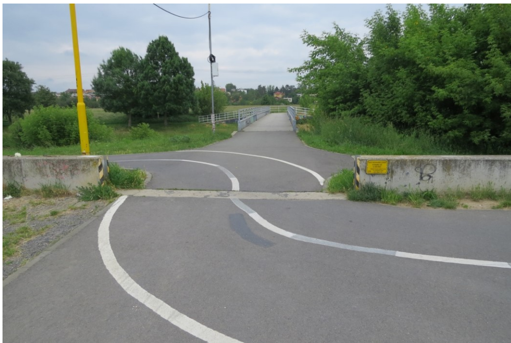
D28 – Ochranná zeď levého břehu. [1]
