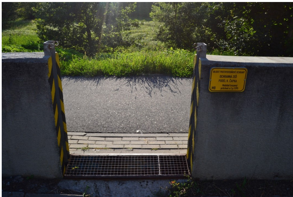
M8 – Mobilně hrazený průchod u č. p. 1594 – ul. K. Čapka. [Vlastní]
