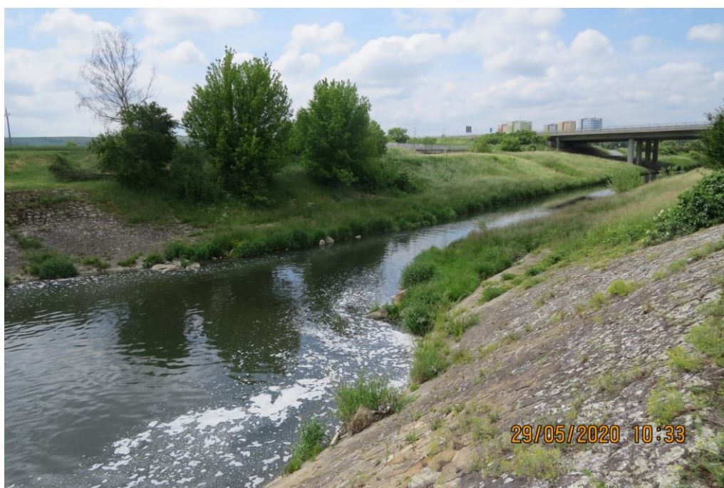
D29 – Koryto mezi jezem a lávkou Kvítkovice (břehové porosty). [1]
