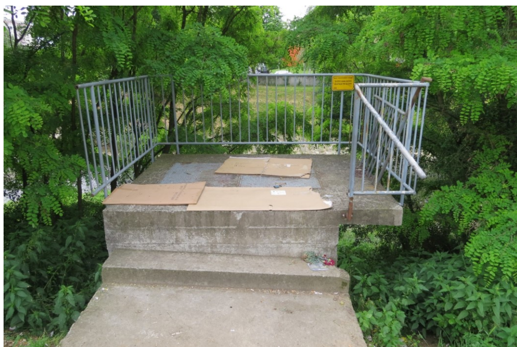
D20 – Šachta s kanalizačním hradítkem pod Besedou. [1]
