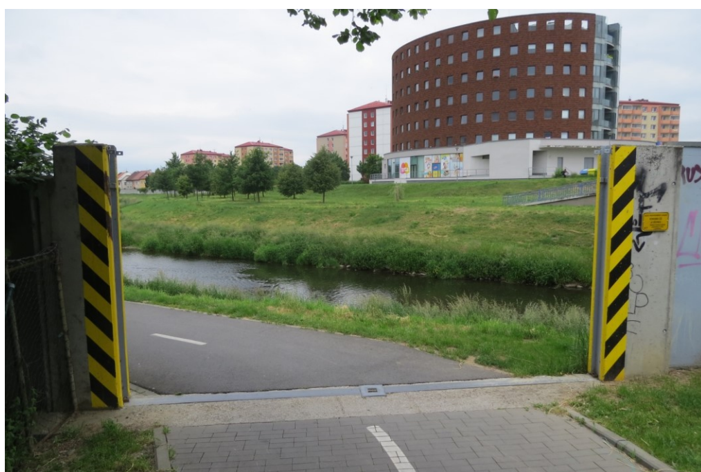
D17 – Ochranná zeď levého břehu – mobilně hrazený průjezd cyklostezky. [1]
