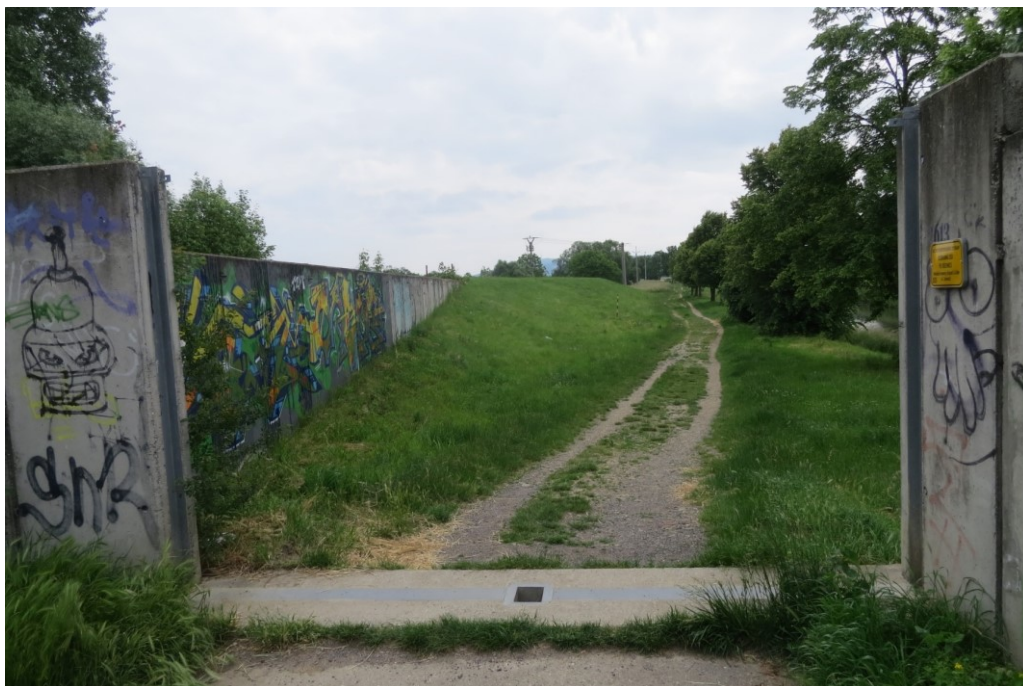
D25 – Ochranná zeď pravého břehu (Mobilně hrazený příjezd). [1]
