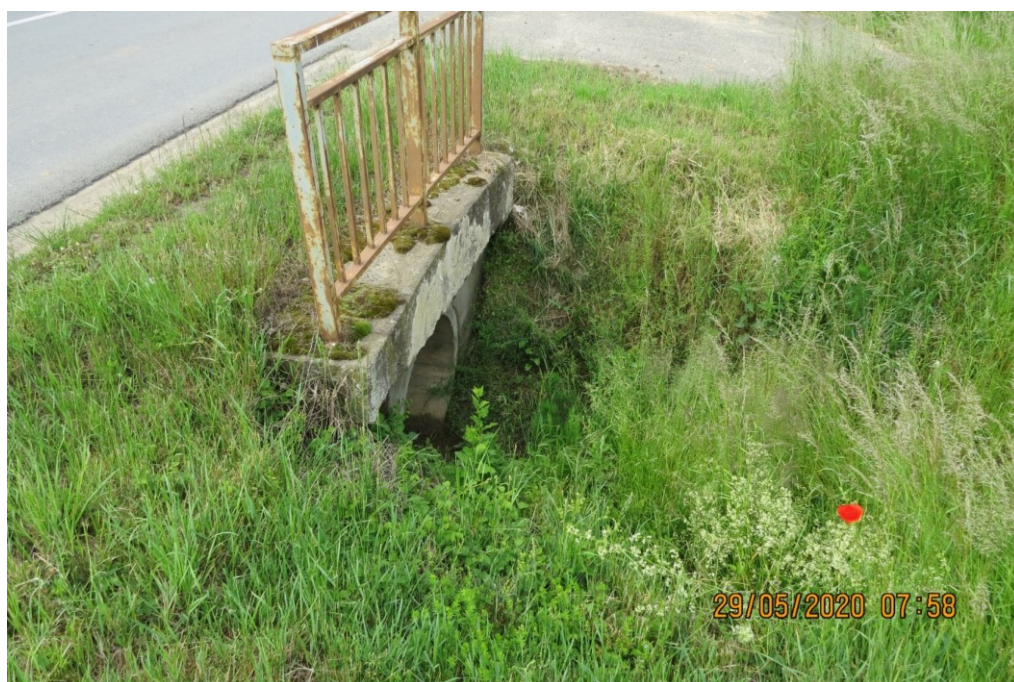
K5 – Propustek příkopy u křižovatky III/4973. [1]
