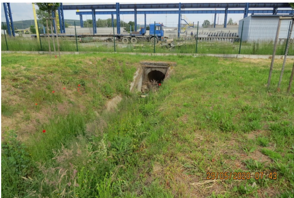
Česla před zatrubněním do PSG. [1]
