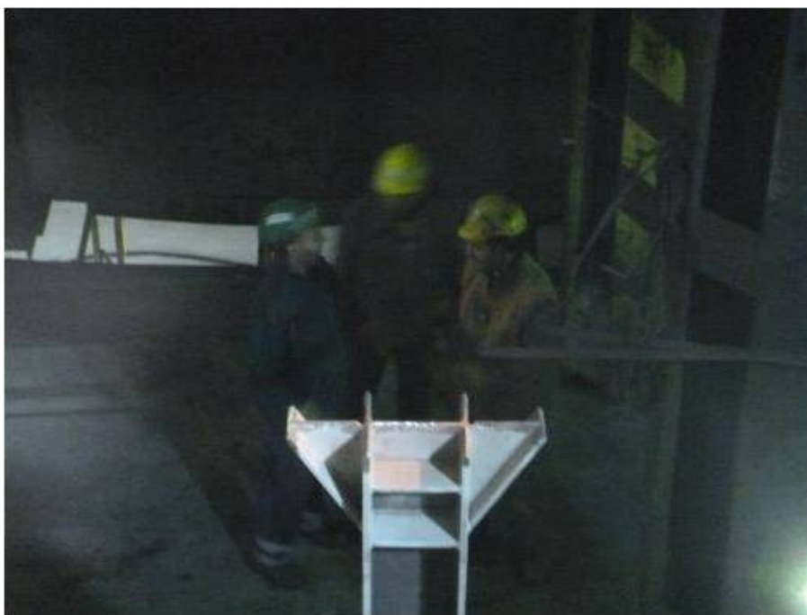
Obrázek 10 - Zaměstnanci vykonávají svou práci bez použití vhodných OOPP (brýle, podbradní pásek).
