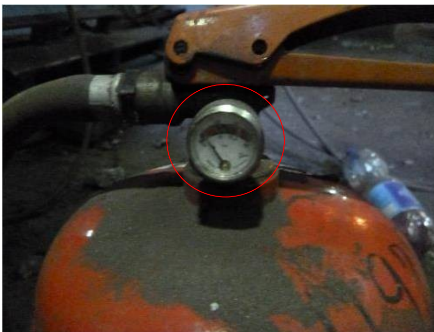
Obrázek 7 - Hasicí přístroj bez tlaku
