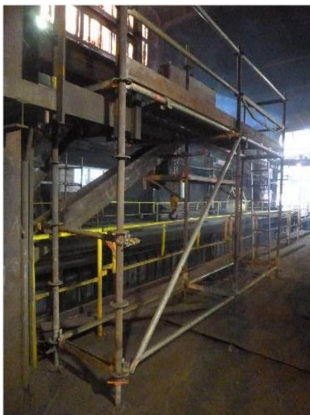
Obrázek 4 - Neoznačené lešení. Lešení bez pravidelné čtrnáctidenní kontroly.
