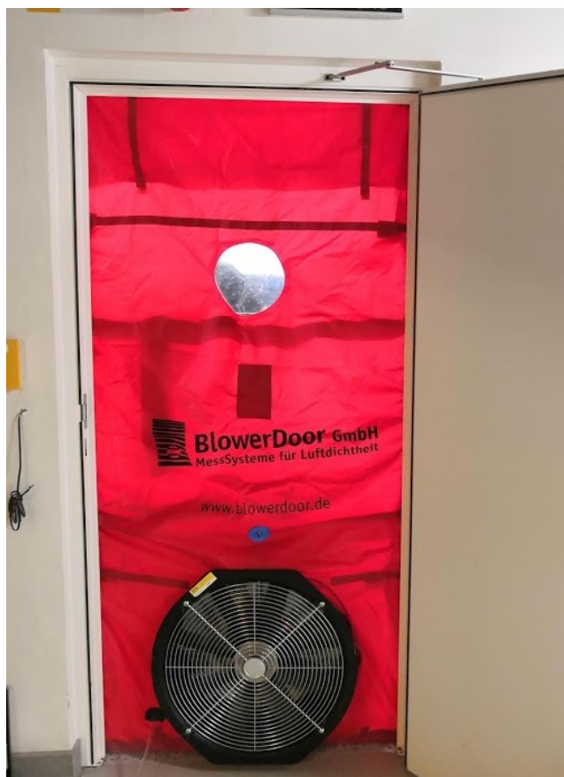
Obr. 14. Plachta s ventilátorem pro provádění „door fan testu“. [vlastní]
