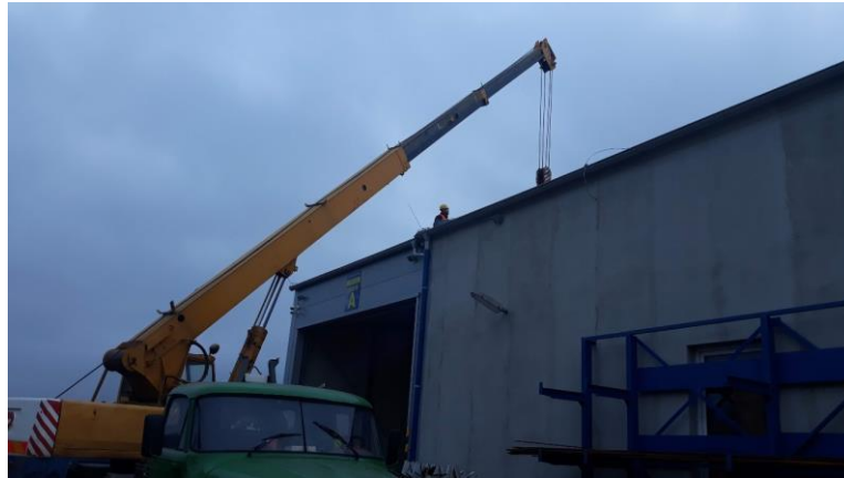
Obrázek 20 Realizace stavby (interní materiály společnosti)
