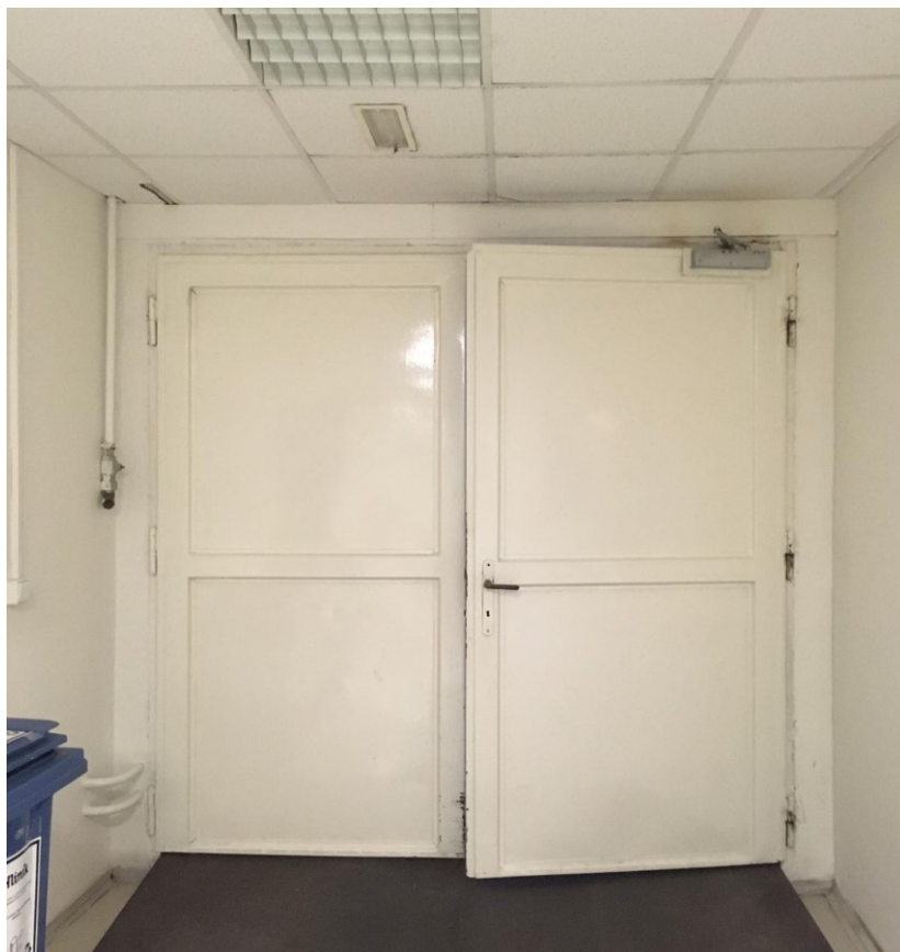
Obrázek 20: Ocelové dveře (vlastní zpracování)
