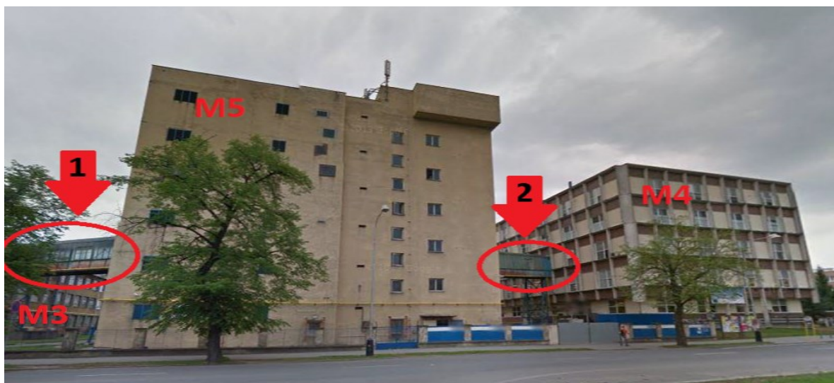
Obrázek 10: Tubusy spojující budovy M3, M4 a M5 (vlastní zpracování)
