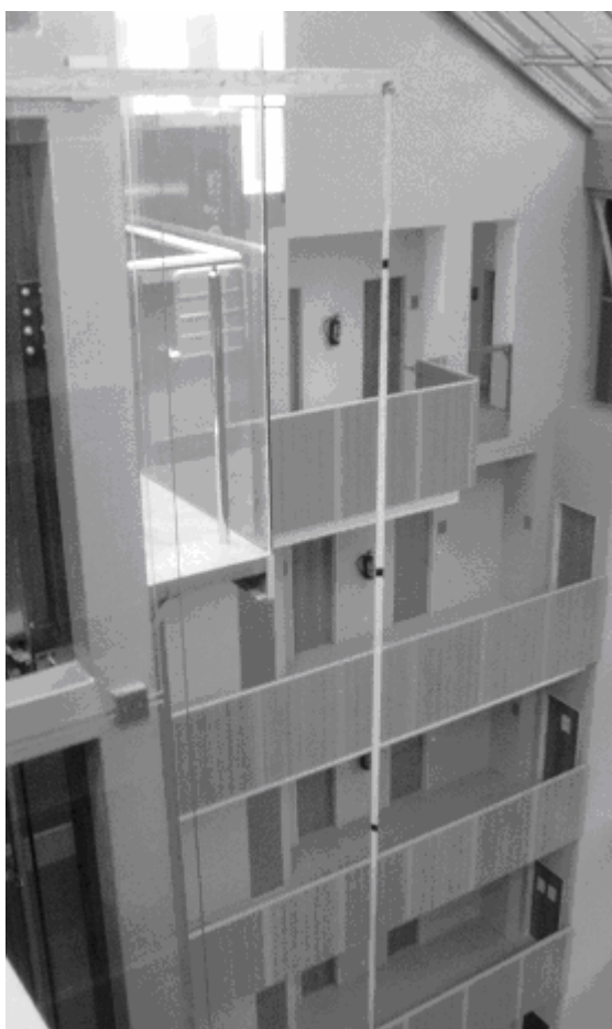
Obr.21: Uchycení nosného kabelu se senzory
