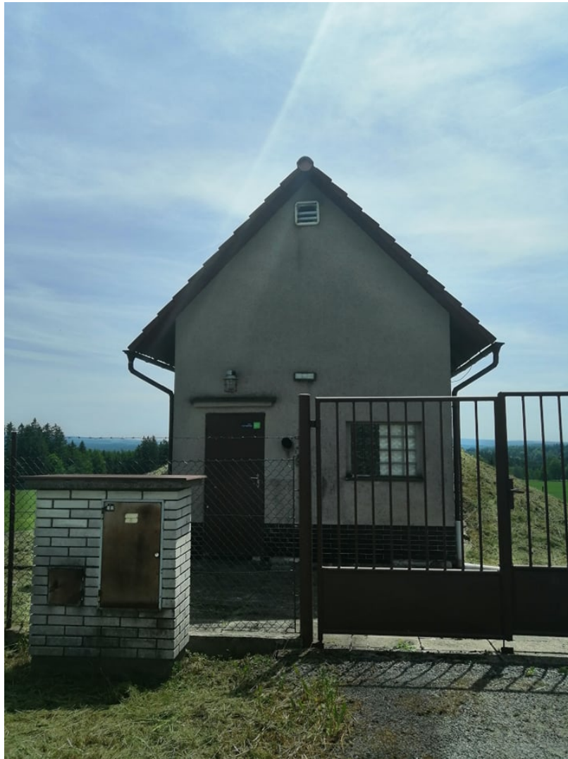
Obr. 2 – Obecní vodárna (Vlastní).
