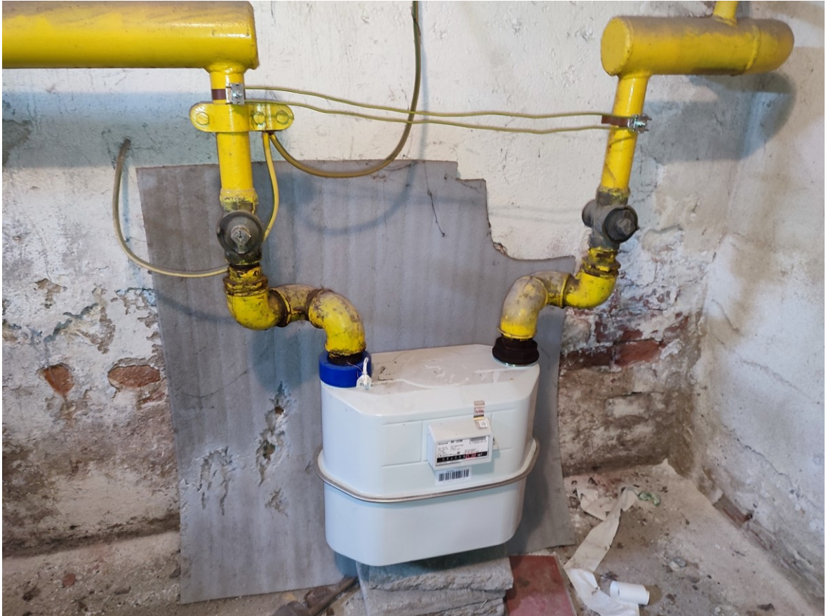
Obrázek 13 – hlavní uzávěr plynu (vlastní)
