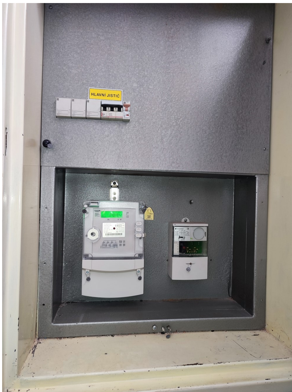
Obrázek 16 – hlavní jistič (vlastní)
