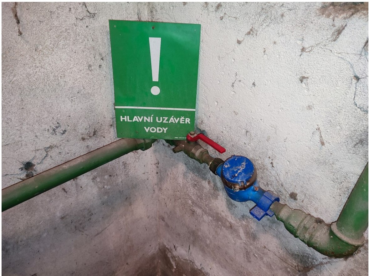
Obrázek 12 – hlavní uzávěr vody (vlastní)
