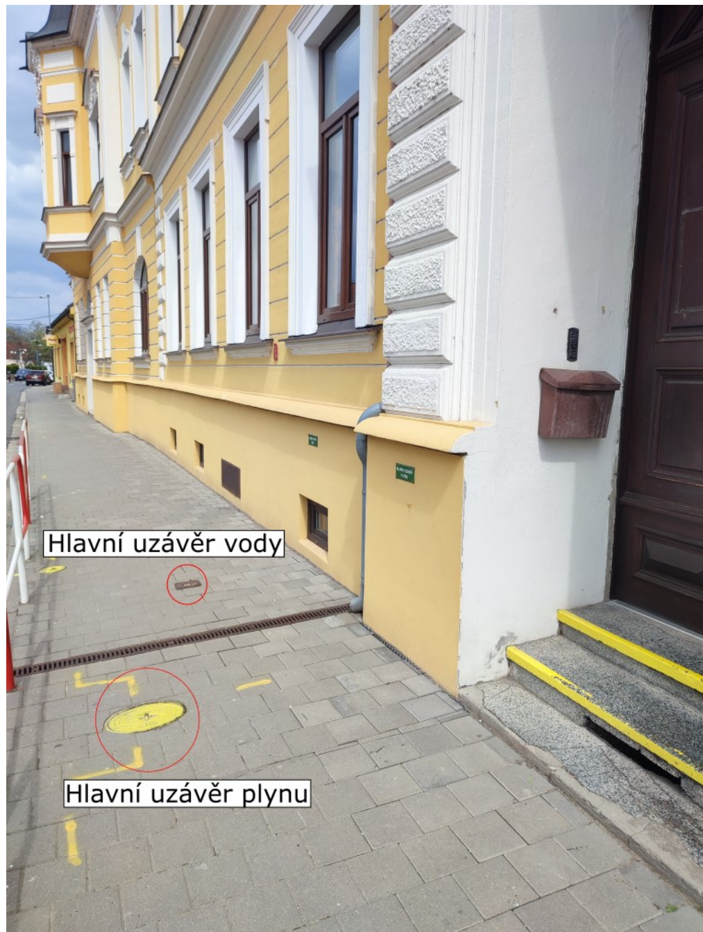
Obrázek 14 – hlavní uzávěry vně budovy (vlastní)
