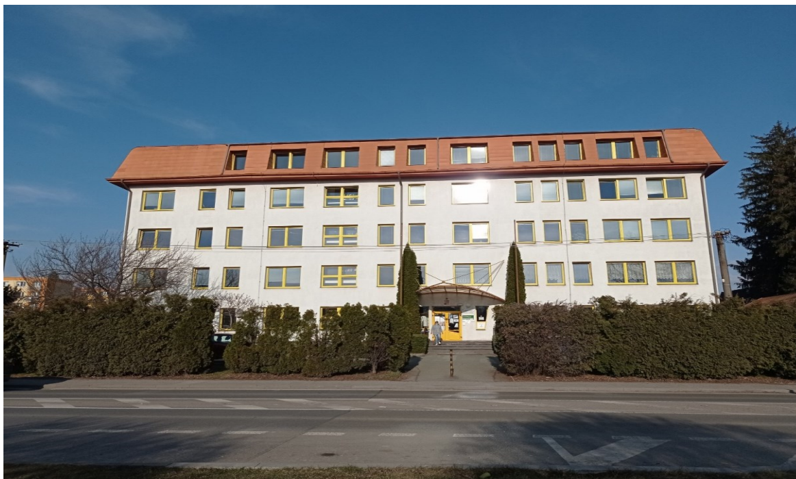
Obrázek 7 - Pohled na přední část budovy ÚP RK – foceno přes pozemní komunikaci č. I/14 (zdroj vlastní)
