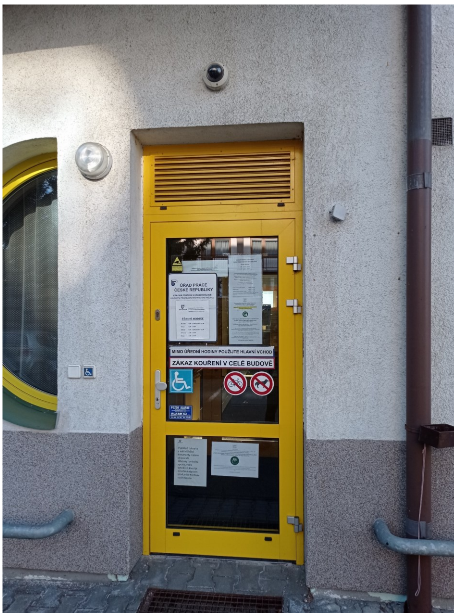
Obrázek 10 - Pohled na zadní vchod do budovy ÚP RK (zdroj vlastní)
