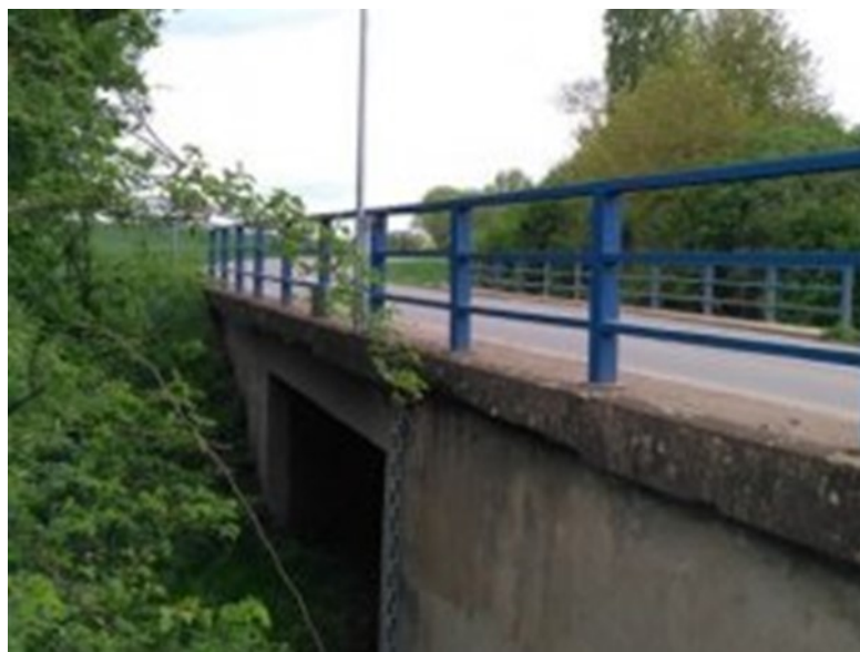
Obr. 3 Hladinoměr na říčce Žlebůvce (Povodňový plán města Němčice nad Hanou, 2018)
