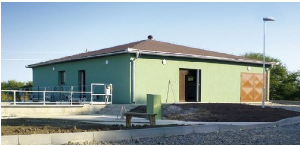
Obr. 4 Čistírna odpadních vod Němčice nad Hanou
