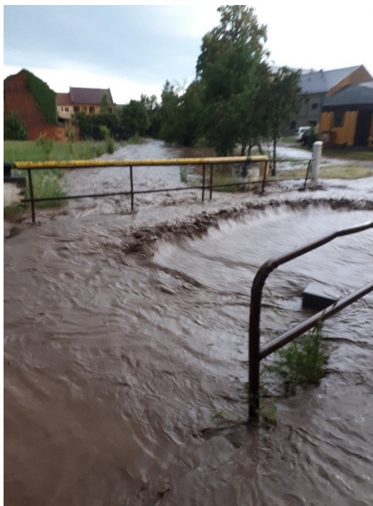
Obr. 8 Rozvodněná říčka Žlebůvka, ulice Novosady v roce 2019
