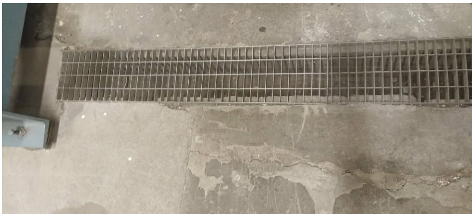
Obrázek 2 – sběrací kanál ve strojovně (Vlastní)
