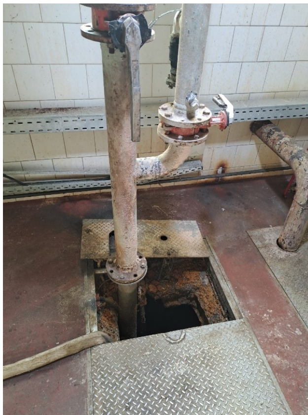
Obrázek 16 – Nezadělaný otvor na ČOV (vlastní)
