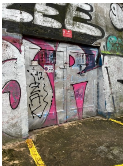
Ocelové dveře vstupu do úkrytu Bezovka. (Vlastní fotografie)
