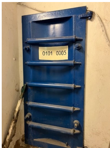
Obrázek 3 – Hermeticky uzavíratelné dveře. (Vlastní fotografie)
