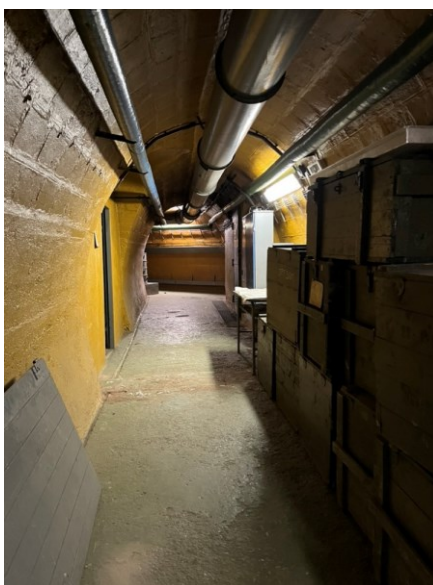
Obrázek 8 – Chodba v úkrytu Keplerova. (Vlastní fotografie)
