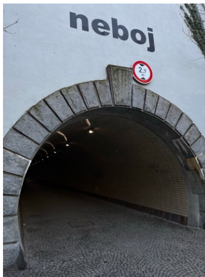
Obrázek 6 – Vchod do Žižkovského tunelu z Karlína. (Vlastní fotografie)
