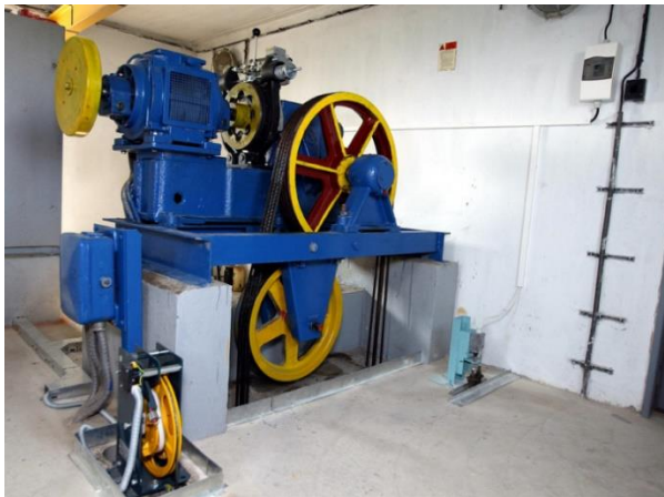
Obrázek 5. Strojovna výtahu. [33]
