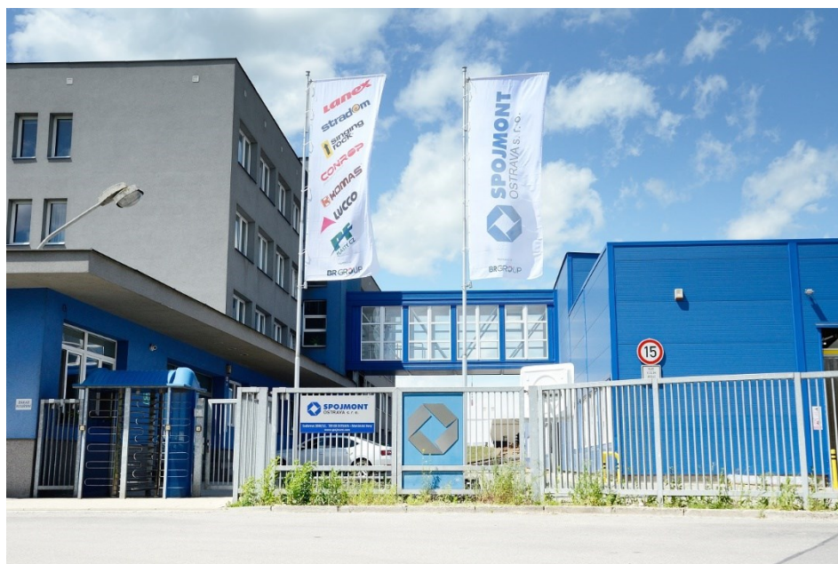
Obrázek 6: Sídlo společnosti Spojmont Ostrava (interní zdroj)
