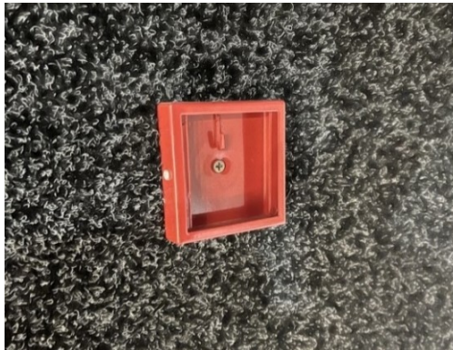
Obrázek 18. Absence klíče pro otevření únikového východu v tělocvičně [vlastní]
