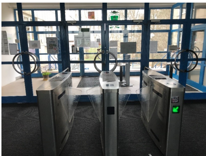
Obrázek 11: Pohled na vstupní turnikety u hlavního vchodu (zdroj: vlastní)
