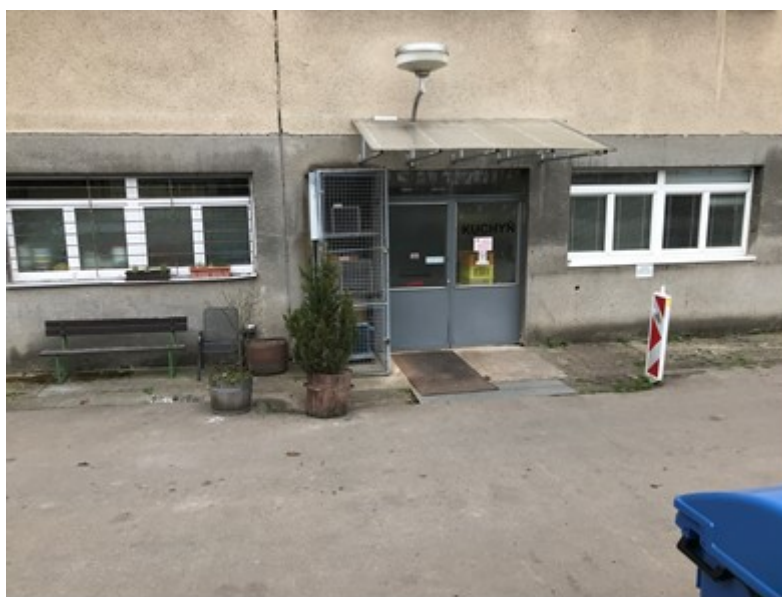
Obrázek 12: Okna a dveře, která nejsou vždy dovřena (zdroj: vlastní)
