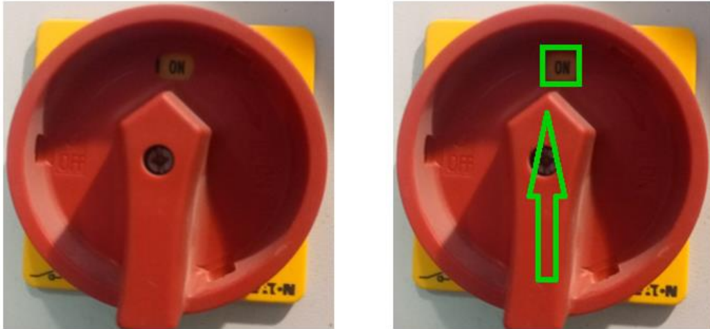
Obrázek 23 Hlavní jistič (zdroj vlastní za využití Mesit foundry)
